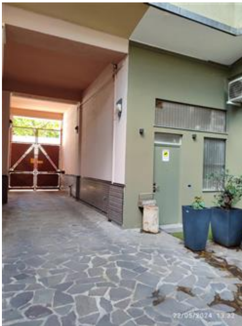
Interno androne comune condominiale
