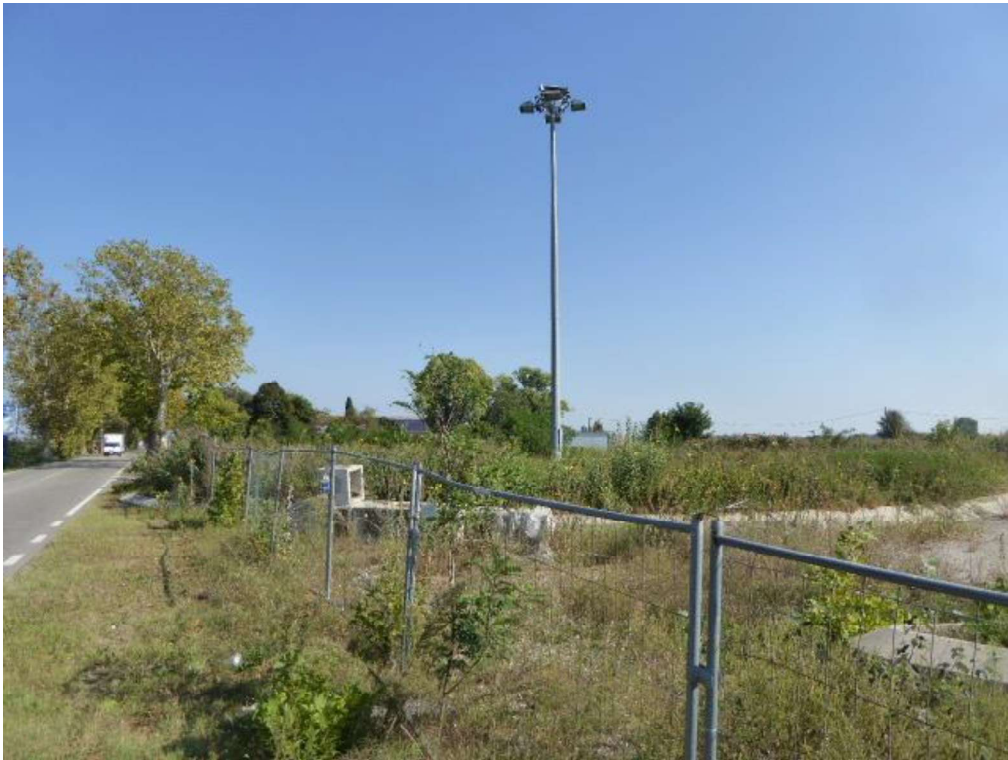
Foto n. 4 – rotonda e impianti in corso d’opera -
