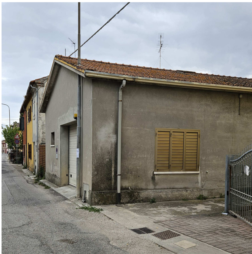
Vista da strada – lato ovest
