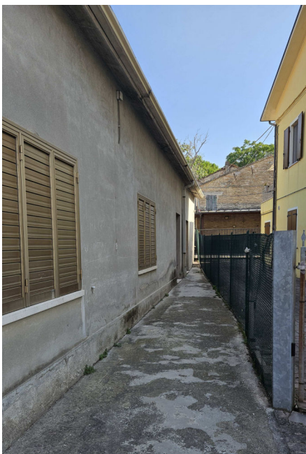
Corridoio d'accesso esterno
