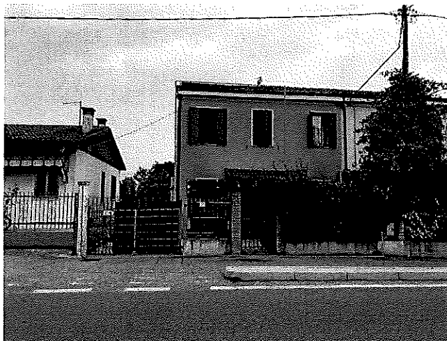
Comune di Bagnoli di Sopra (PD), via Fratelli Bandiera n. 91
