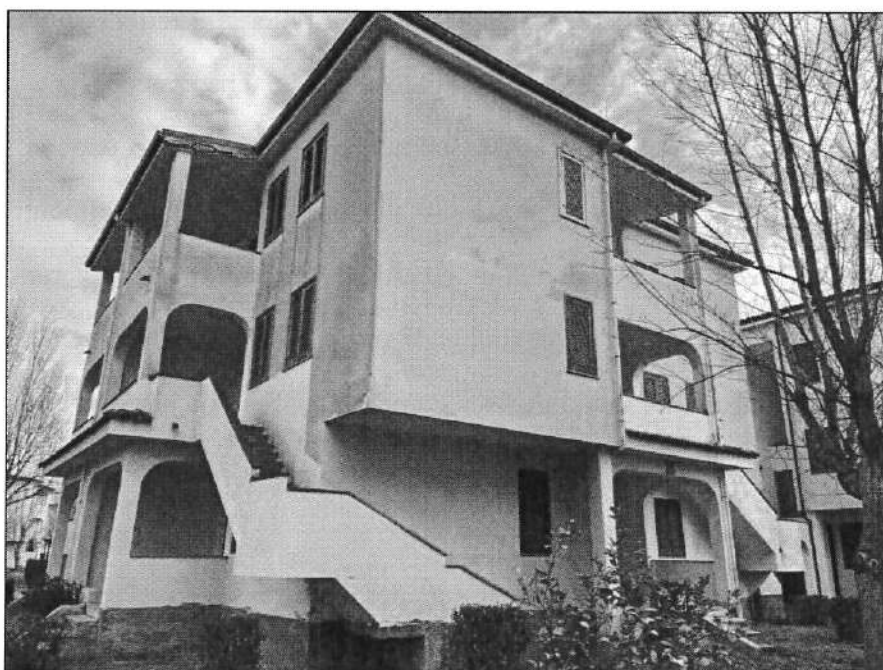
Foto 13 – Fabbricato B, part. 1150.
