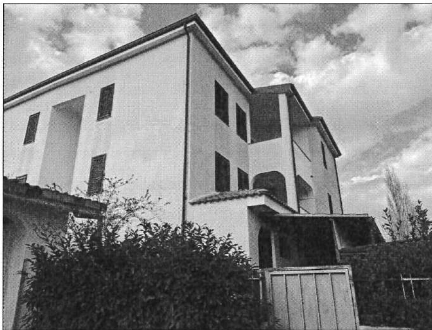
Foto 25 - Fabbricato W, part. 823.
