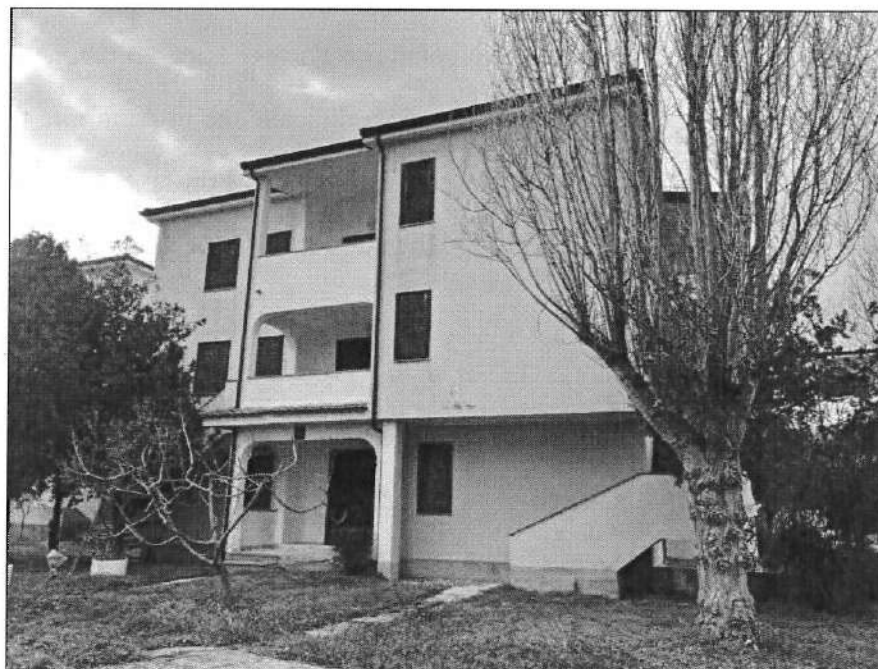
Foto 19 – Fabbricato H, part. 1148.
