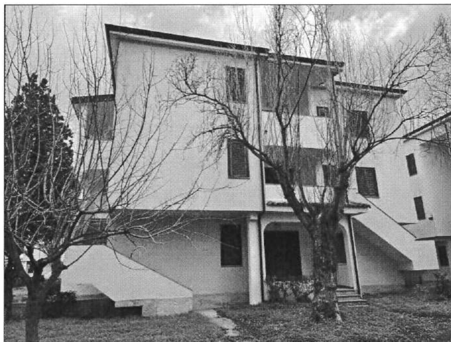
Foto 20 – Fabbricato I, part. 1145.
