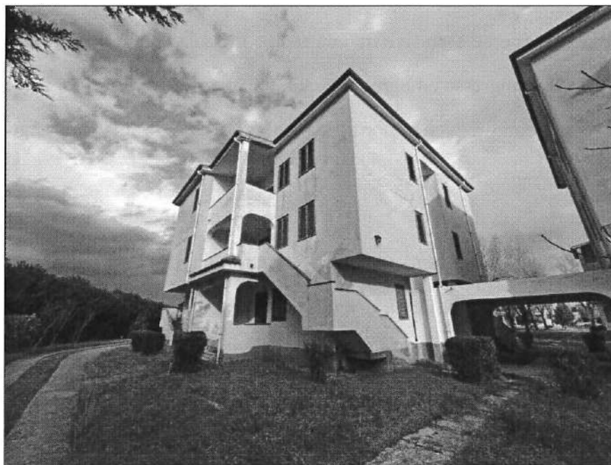
Foto 15 – Fabbricato D, part. 1154.
