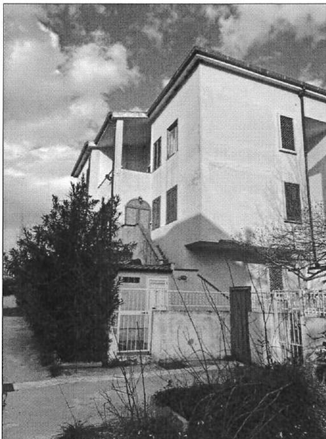
Foto 22 – Fabbricato V, part. 824
