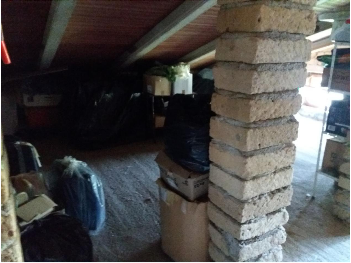
FOTO SOFFITTA P.2° SUB.7
