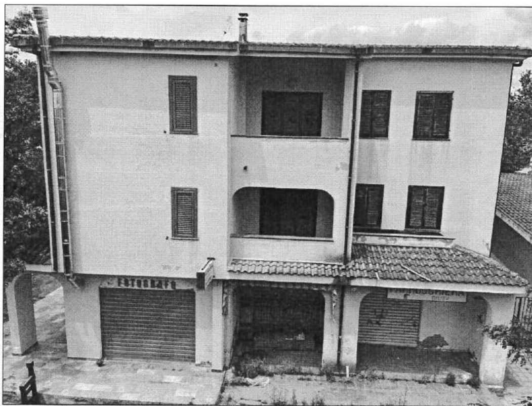
Fig. 10 – Fabbricato part. 823 – Palazzina K
