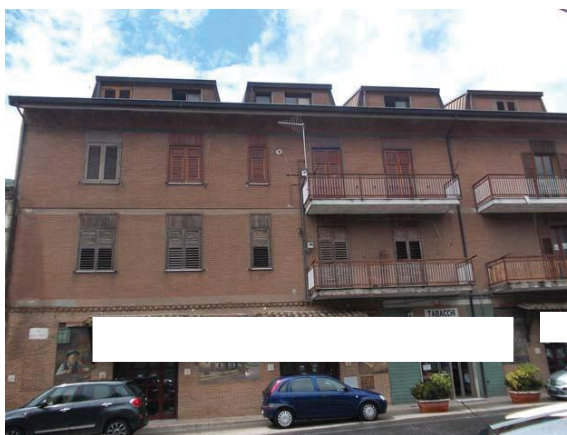
4 | vista del fabbricato: al piano terzo mansardato gli abbaini dell'alloggio sub 10
