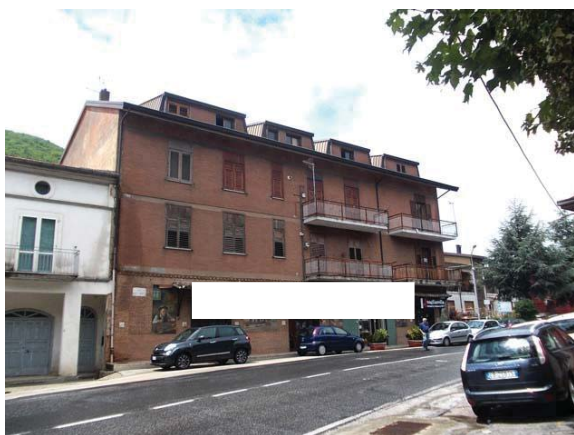
3 | vista del fabbricato da via morelli e silvati
