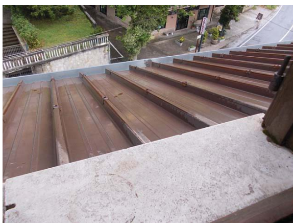
18 | particolare lamiera grecata della copertura
