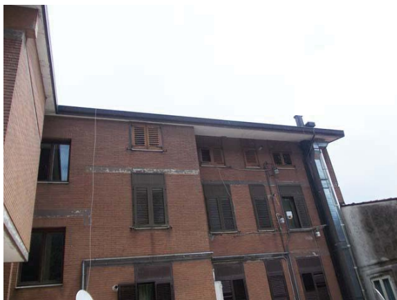
5 | vista del fabbricato: al piano terzo alloggio sub 11
