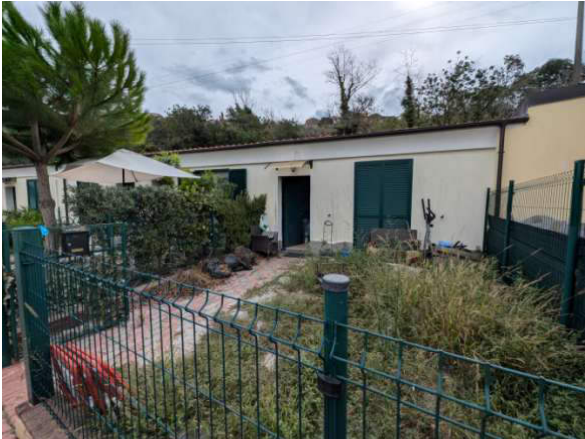
Fotografia 1: il fabbricato lato ingresso
