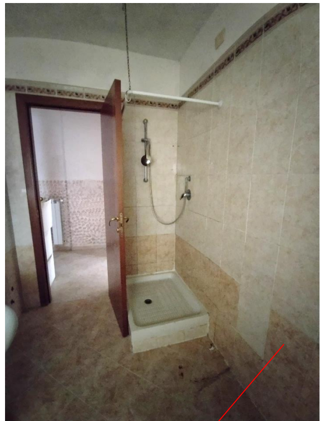
Parete bagno a confine con il vano letto
