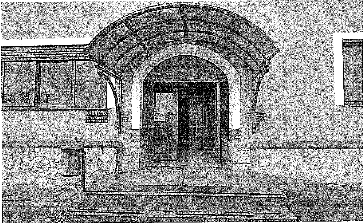
INGRESSO PROSPETTO NORD/EST
