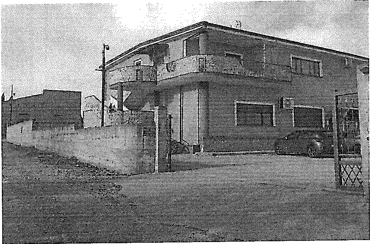
PARTICOLARE INGRESSO FABBRICATO
