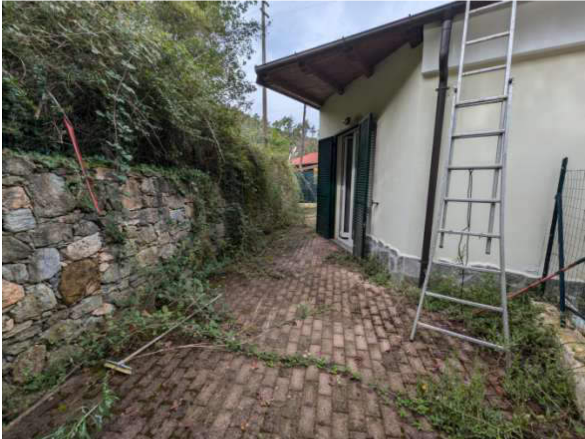
Fotografia 5: corte a sud e ovest
