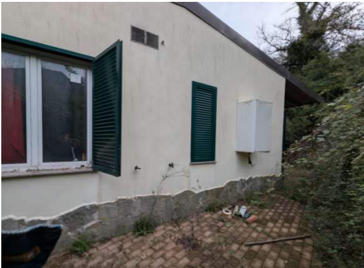
Fotografia 6: corte a sud e ovest
