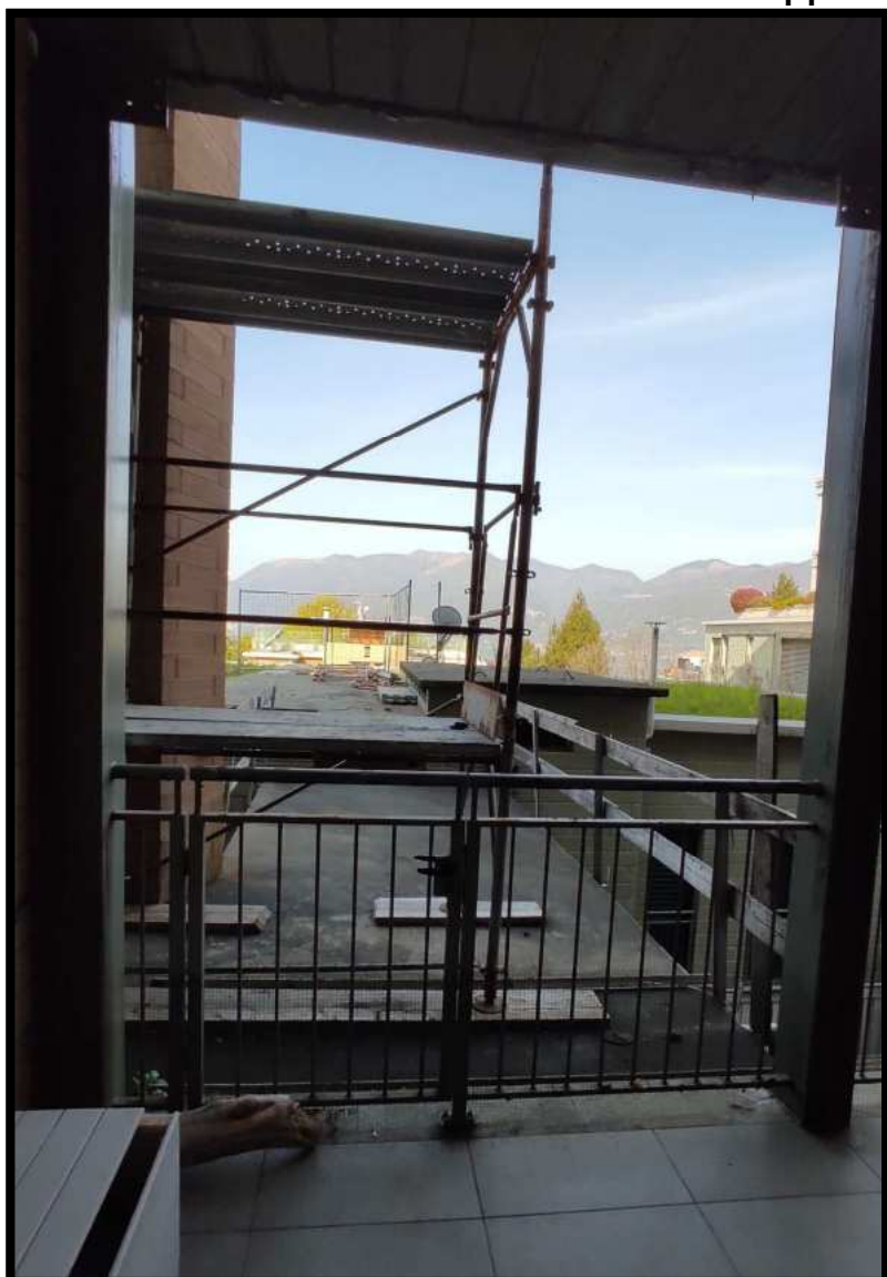
Passerella per accesso al giardino pensile
