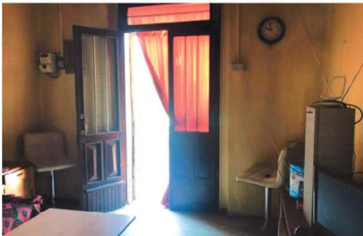
FOTO 6 - 1.a Piano terra, ingresso
