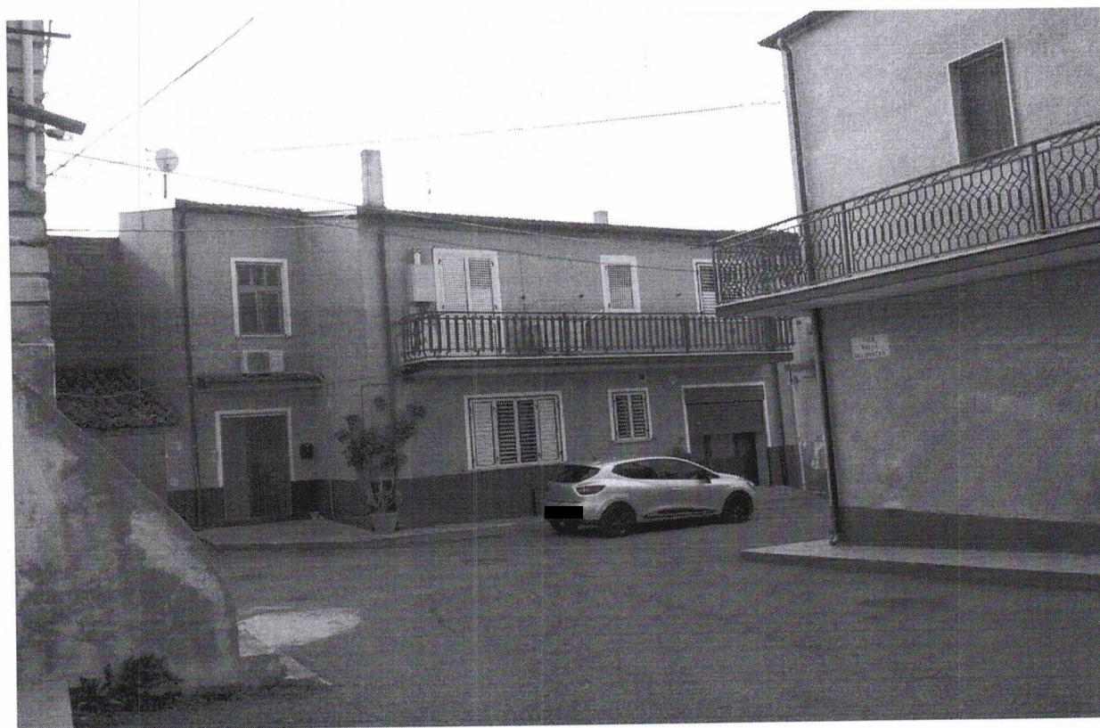
VISTA ESTERNA DEL LOTTO 1) – Da Via Della Resistenza –
