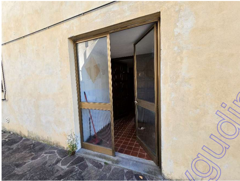
serramento da rimuovere
