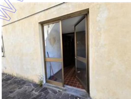
porta d'ingresso in alluminio da rimuovere
