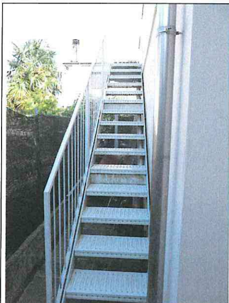
Foto n°59: Scale di accesso a terrazza sopra garage
