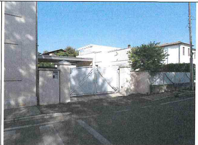
Foto n°6: Unico cancello sia pedonale che carroia
