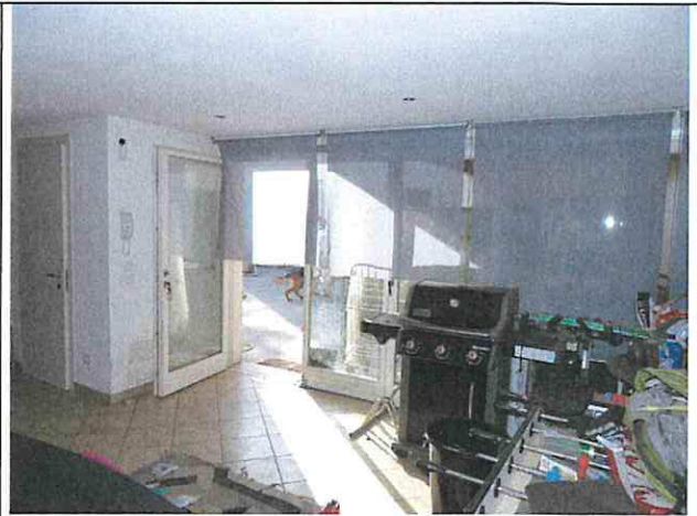
Foto n°54: Altra vista garage – locale pluriuso – a nord-est
