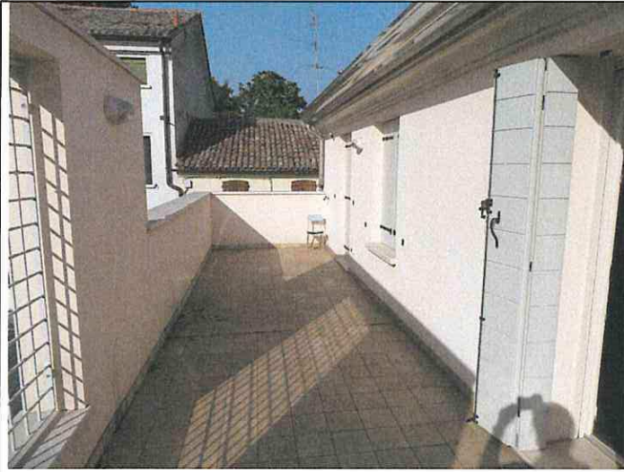
Foto n°43: Vista terrazza al P.1° verso nord
