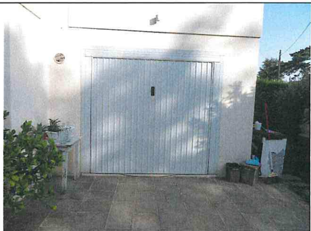
Foto n°57: Garage a sud est
