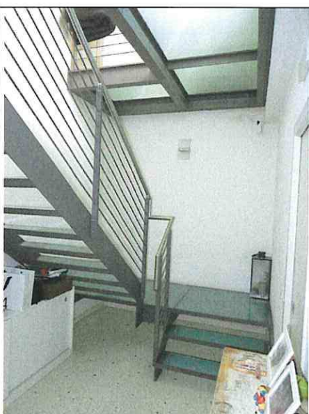
Foto n°27: Scale di accesso al primo livello
