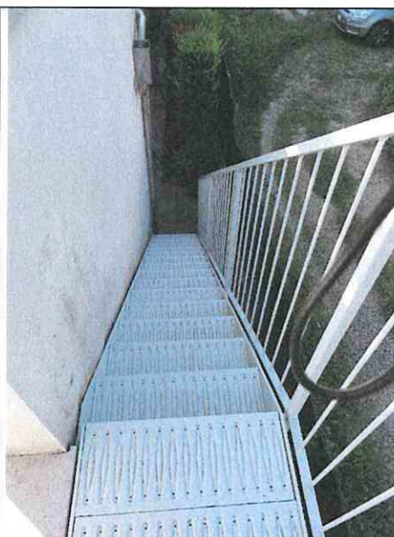
Foto n°60: Scale di accesso a terrazza sopra garage
