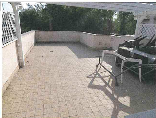
Foto n°61: Terrazza sopra garage verso sud
