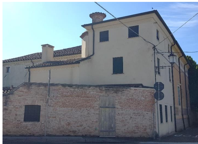
Vista della porzione di edificio al grezzo
