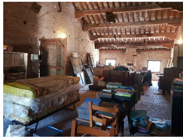
Sottotetto della Villa Cantarella
