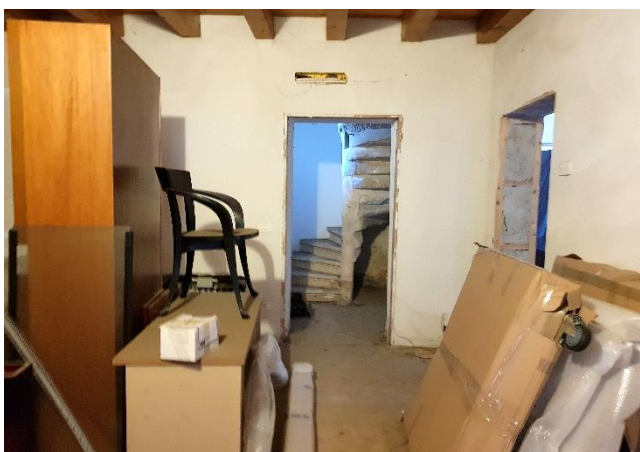
Vista dei locali interni dell'abitazione al grezzo
