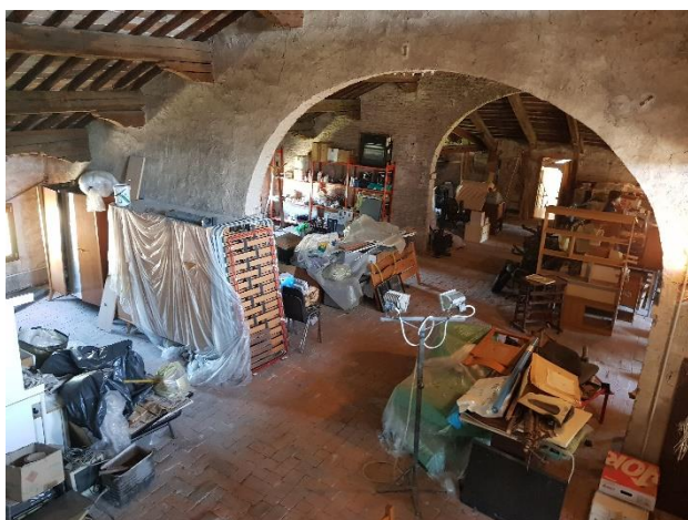
Sottotetto della Villa Cantarella
