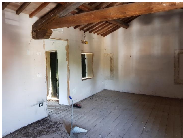
Vista dei locali interni dell'abitazione al grezzo
