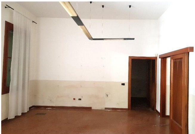
Vista dell'ufficio lato est fronte strada
