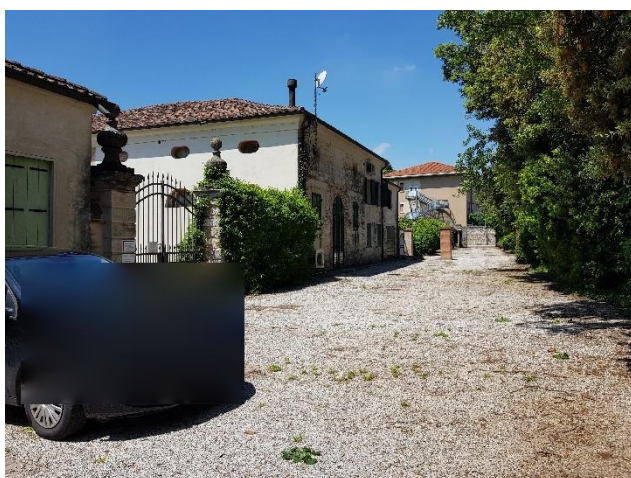
Strada di accesso di servizio
