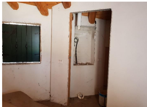
Vista dei locali interni dell'abitazione al grezzo
