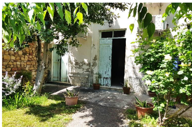
Vista della portafinestra di uscita su altra proprietà.
