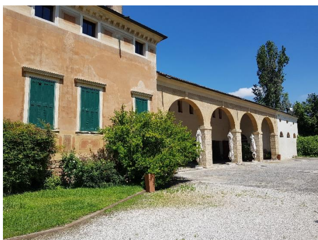
Villa Cantarella facciata Sud
