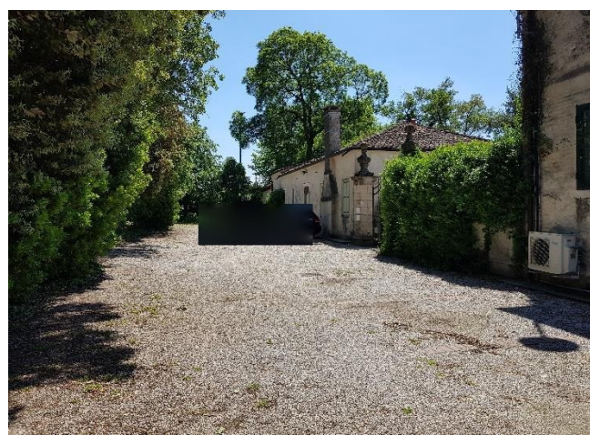
Strada di accesso di servizio
