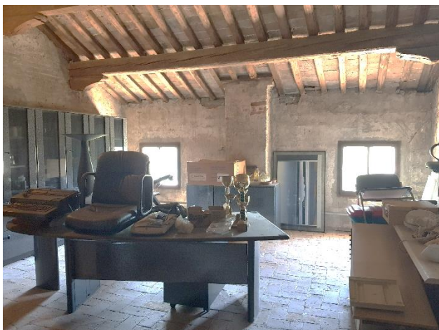
Sottotetto della Villa Cantarella
