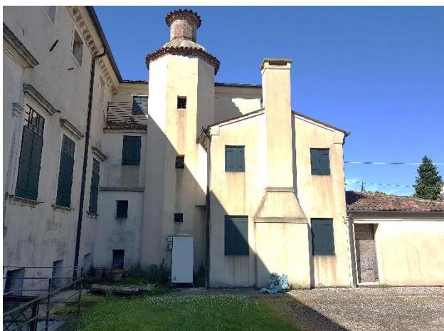
Vista della porzione di edificio al grezzo
