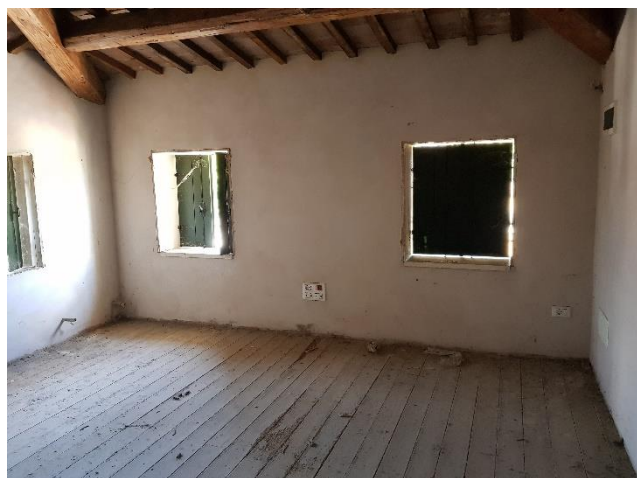
Vista dei locali interni dell'abitazione al grezzo
