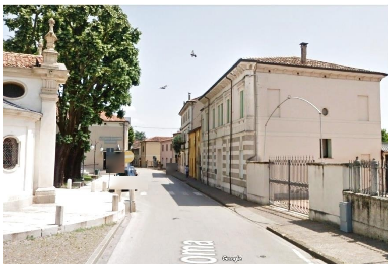
Vista della facciata su via Roma
