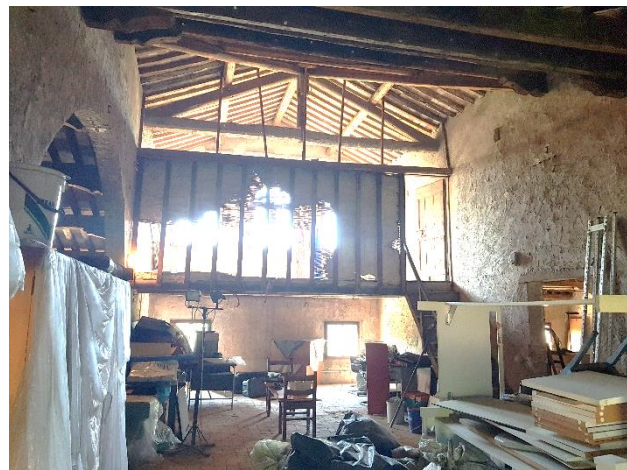
Sottotetto della Villa Cantarella
