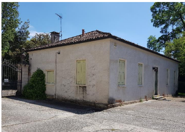
Vista delle ex serre adibite ad ufficio
