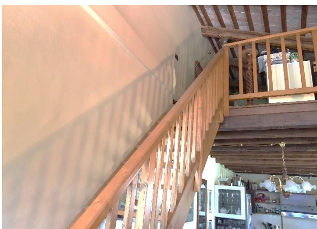
Vista della scala collegamento con il soppalco
