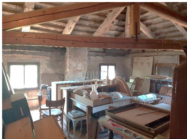
Sottotetto della Villa Cantarella
