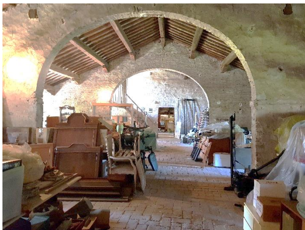
Sottotetto della Villa Cantarella
