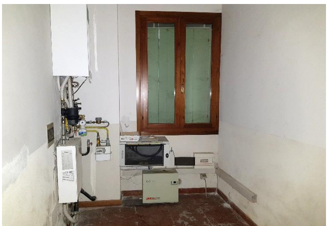
Vista dell'archivio lato sud – est
