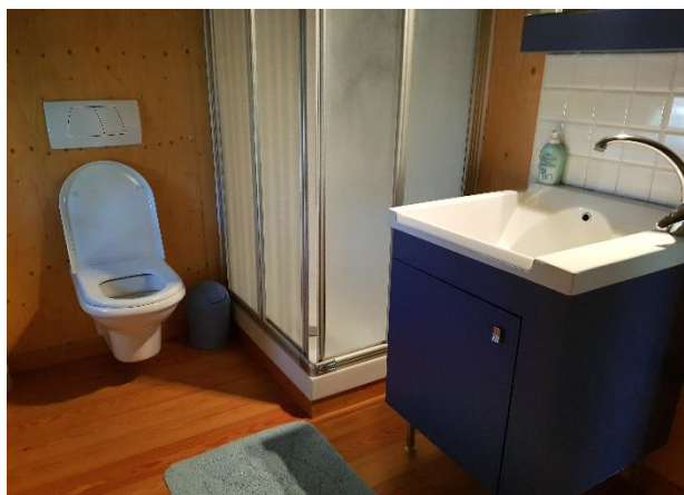
Vista del bagno
