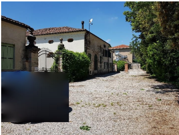
Strada di accesso di servizio
