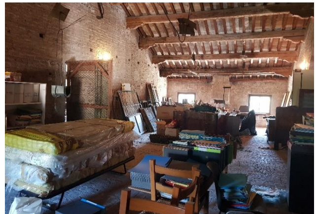
Sottotetto della Villa Cantarella
