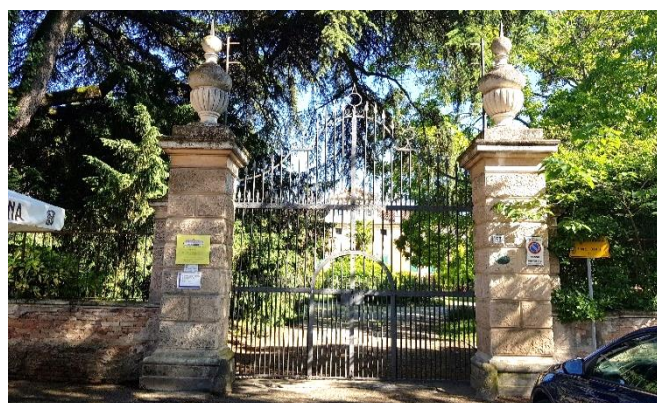
Ingresso principale della Villa
