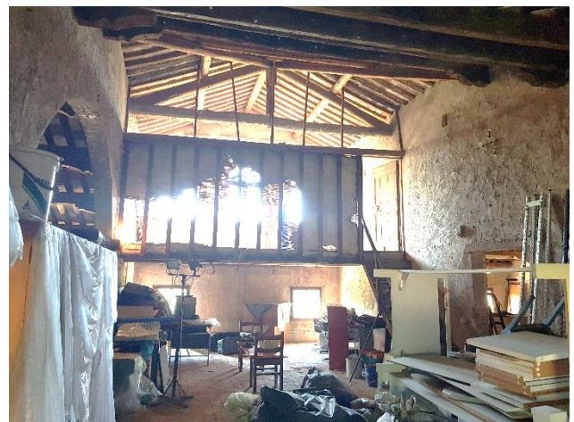
Sottotetto della Villa Cantarella
