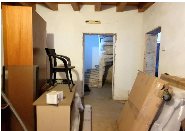
Vista dei locali interni dell'abitazione al grezzo
