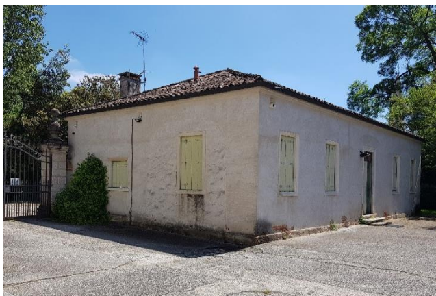
Vista delle ex serre adibite ad ufficio
