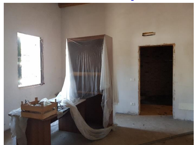
Vista dei locali interni dell'abitazione al grezzo
