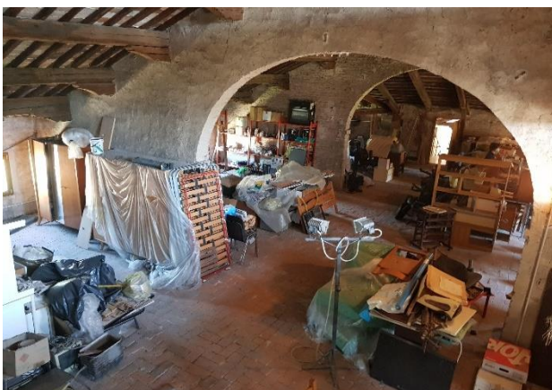
Sottotetto della Villa Cantarella
