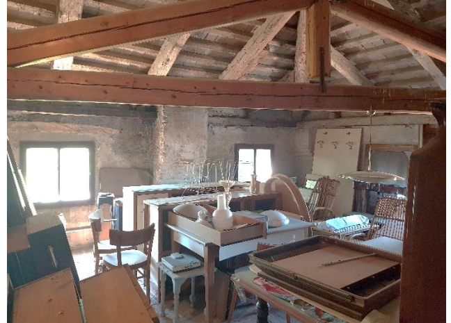
Sottotetto della Villa Cantarella
