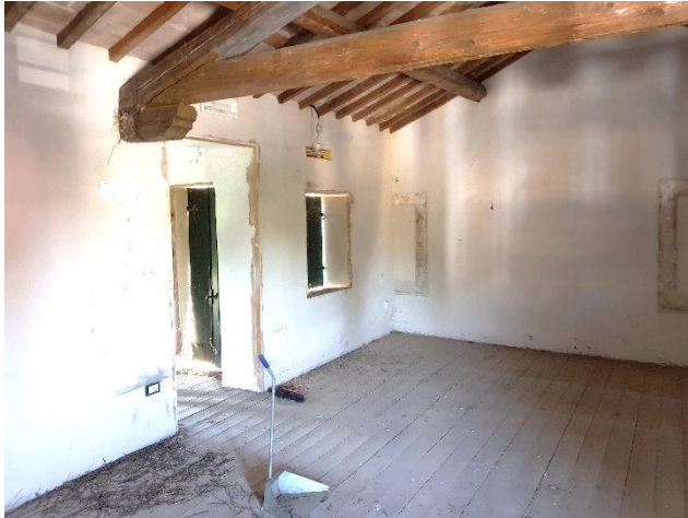
Vista dei locali interni dell'abitazione al grezzo
