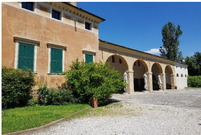
Villa Cantarella facciata Sud
