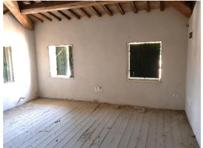
Vista dei locali interni dell'abitazione al grezzo
