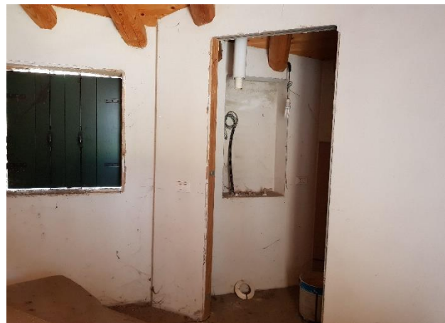
Vista dei locali interni dell'abitazione al grezzo
