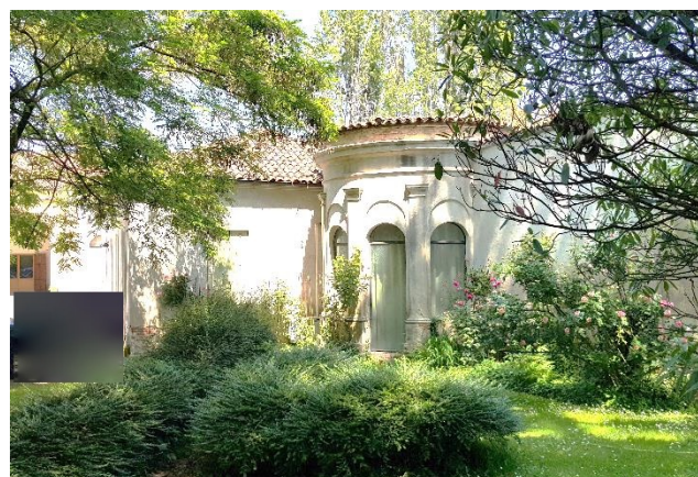
Vista delle ex serre adibite ad ufficio
