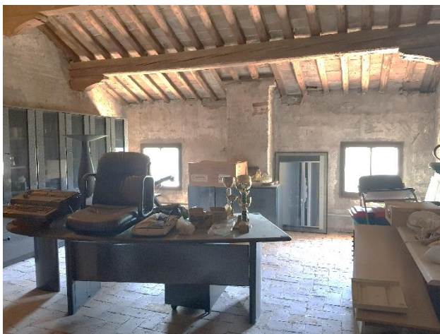
Sottotetto della Villa Cantarella
