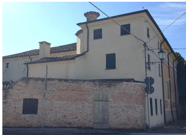
Vista della porzione di edificio al grezzo
