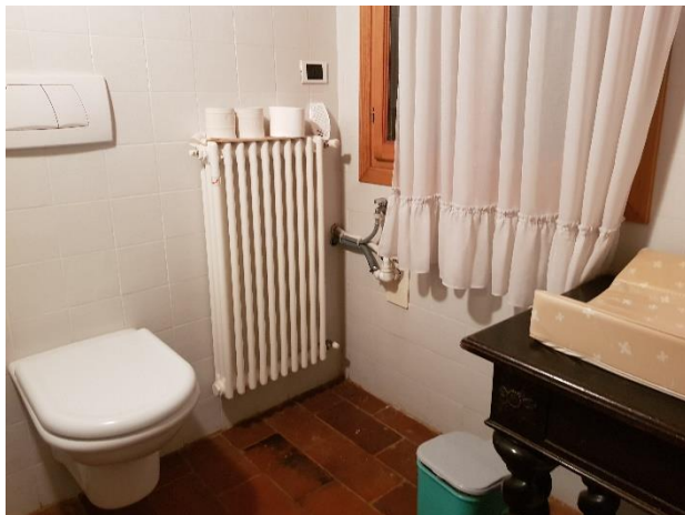
Vista del servizio igienico
