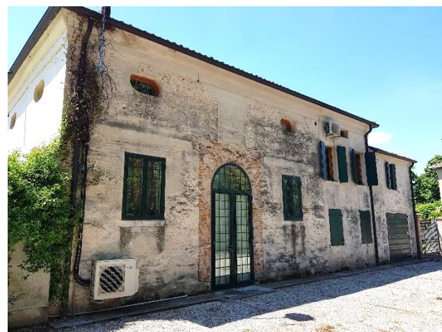
Vista esterna della porz.ne fabbricato uso soggiorno estivo
