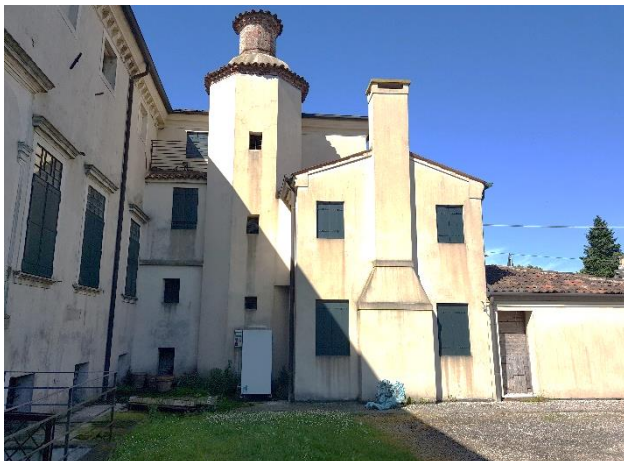
Vista della porzione di edificio al grezzo
