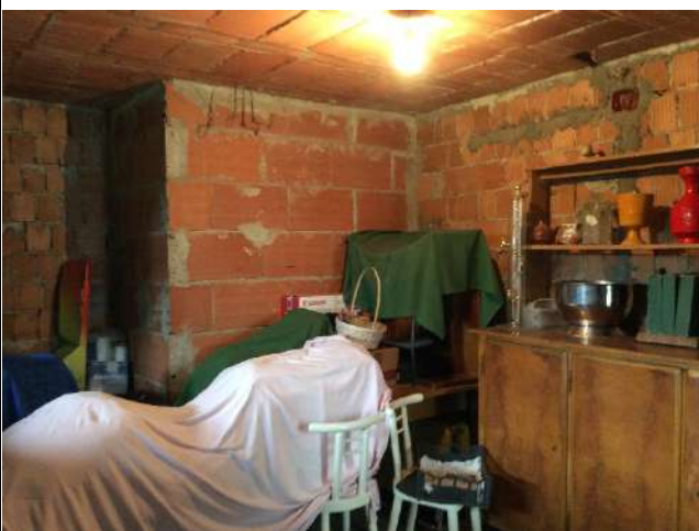
Foto 11: PT - Cantina (sub 4)
