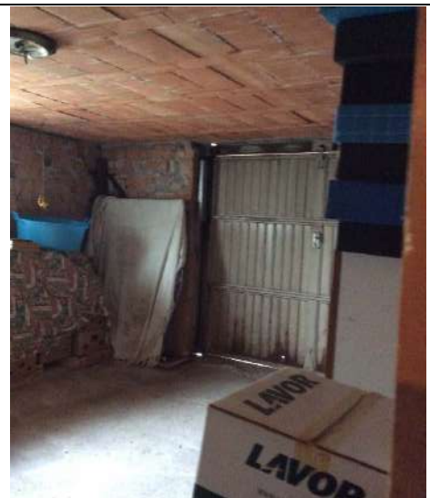
Foto 12: PT - Garage (sub 5)
