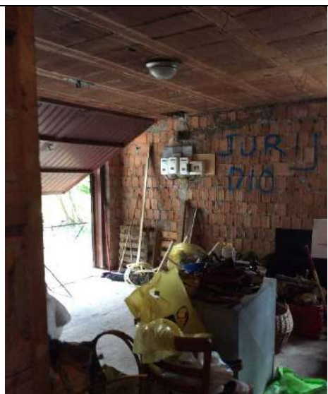
Foto 12: PT - Garage (sub 2)
