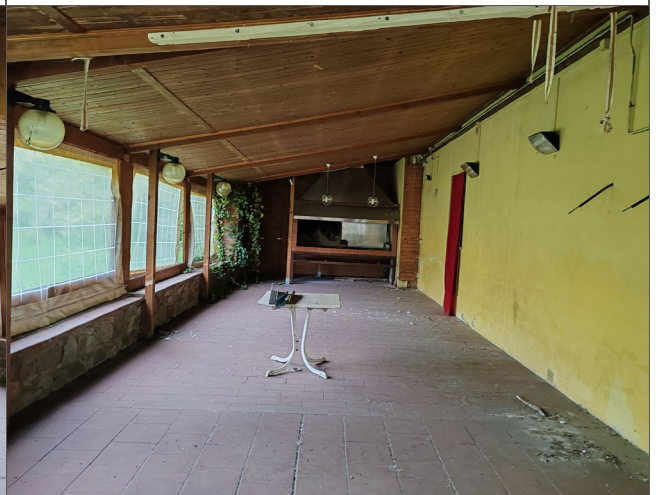
foto n.16 – veranda 5 e taverna da demolire (loc.104 e 105)
