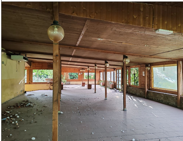
foto n.15 – veranda 3 da demolire (loc.n.102)
