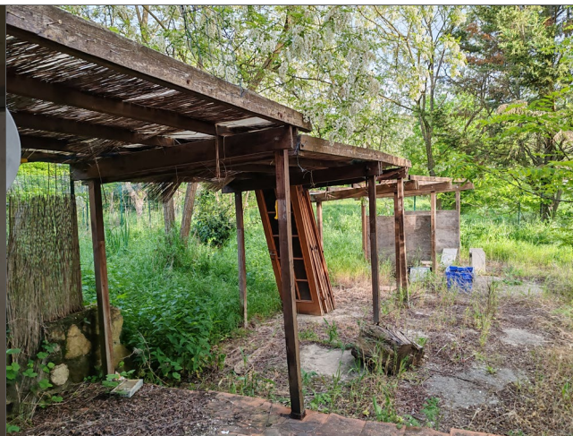
foto n.20 – tettoie 1, 2 e 3 da demolire (loc.n.109, 110 e 111)
