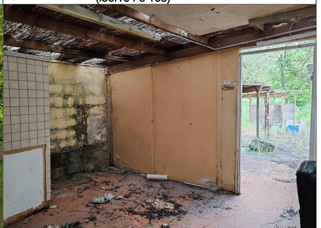
foto n.18 – deposito 3 da demolire (loc.108)
