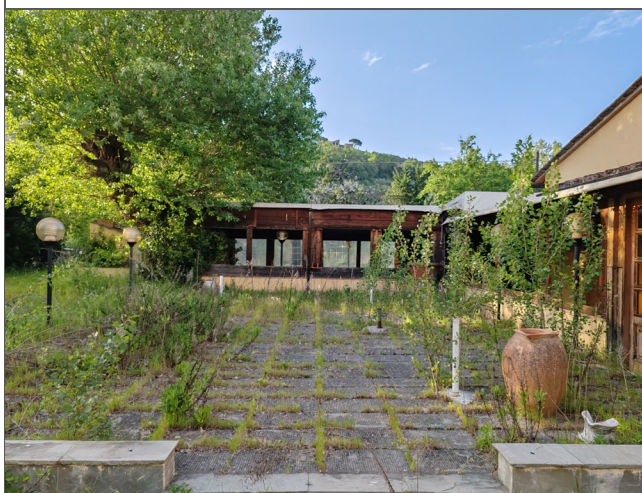
foto n.21 – resede esterna pavimentazione da demolire (loc.n.28)
