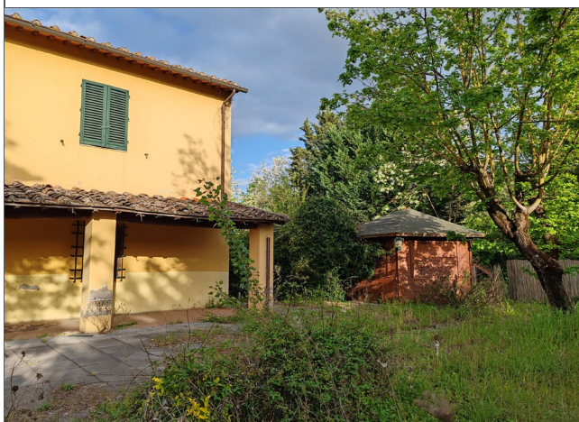
foto n.17 – vista gazebo da demolire (loc.112)
