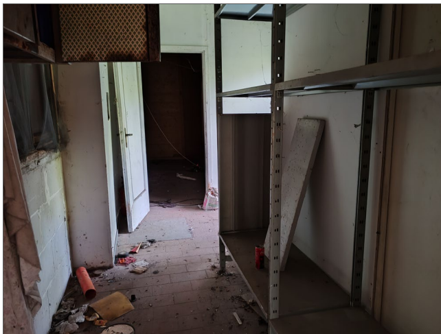
foto n.19 – deposito 2 da demolire (loc.107)
