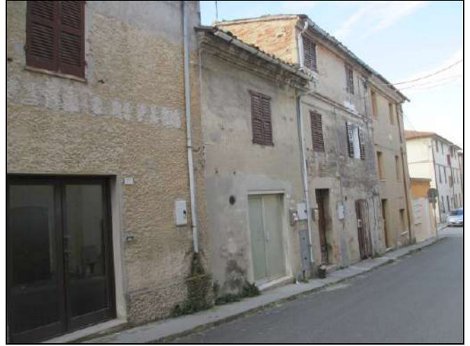
Foto n. 2: Vista esterna fabbricato.
