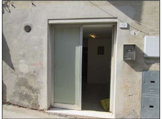
Foto n. 4: Vista ingresso da via Mazzini.
