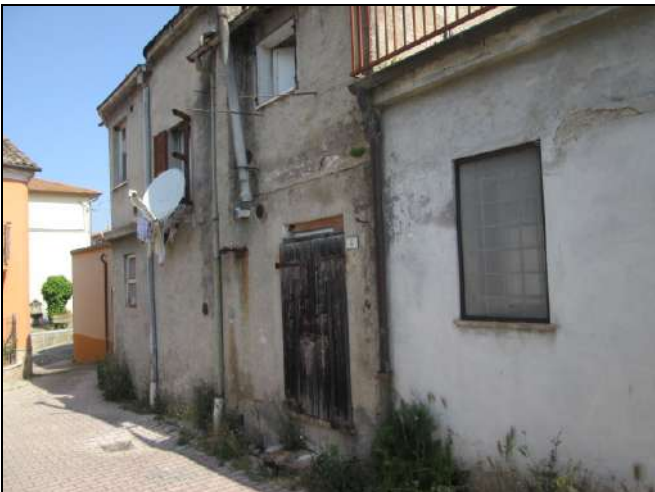
Foto n. 5: Vista esterna fabbricato (retro).
