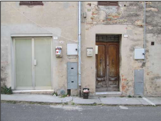
Foto n. 3: Vista esterna fabbricato.
