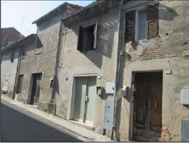
Foto n. 1: Vista esterna fabbricato.
