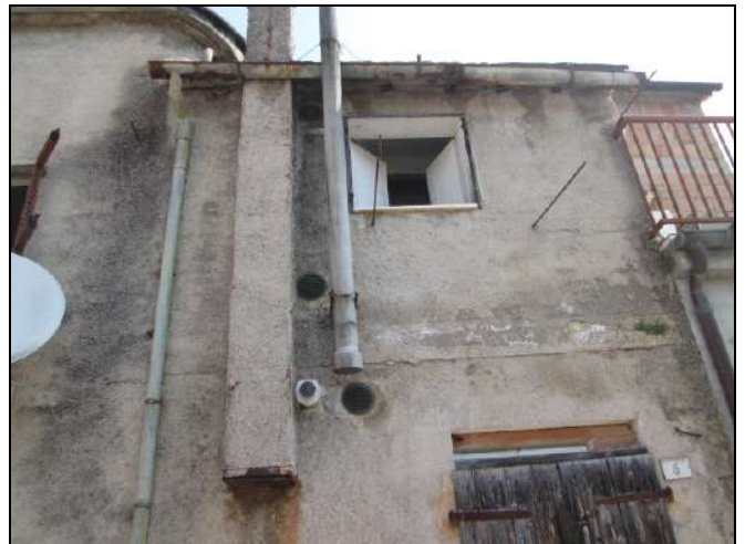
Foto n. 6: Vista esterna fabbricato (retro).
