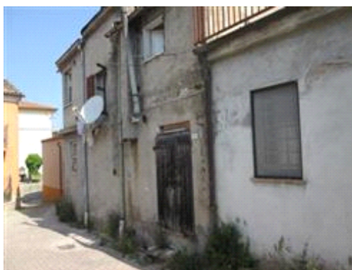
vista esterna fabbricato
