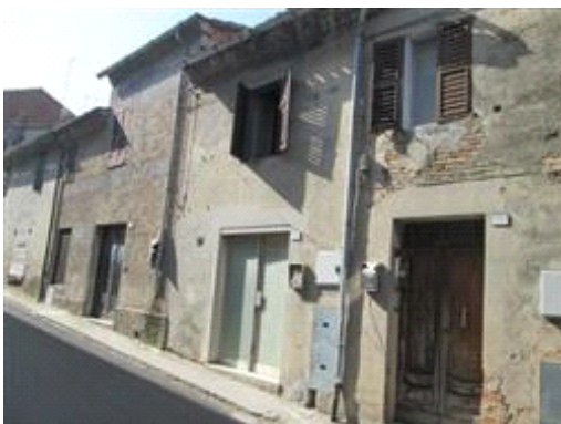
vista esterna fabbricato
