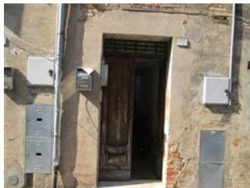
vista accesso al fabbricato
