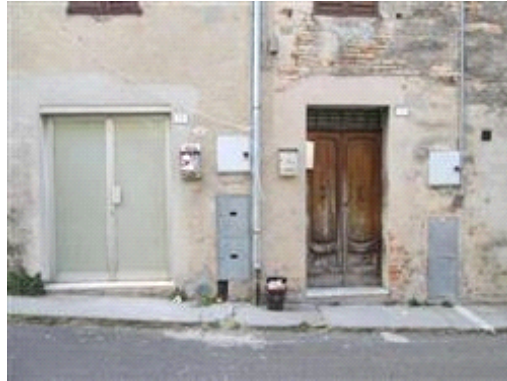
vista esterna fabbricato
