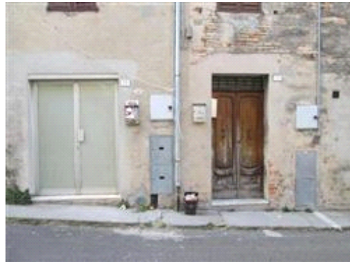
vista esterna fabbricato
