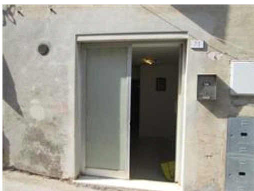
vista esterna fabbricato
