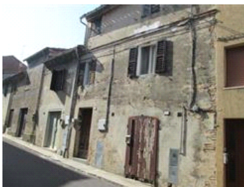
vista esterna fabbricato
