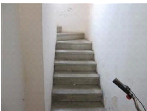
vista scala condominiale
