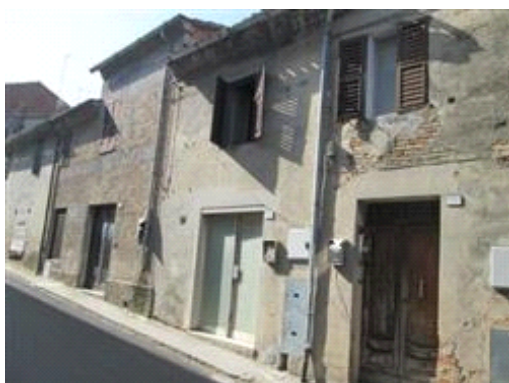
vista esterna fabbricato
