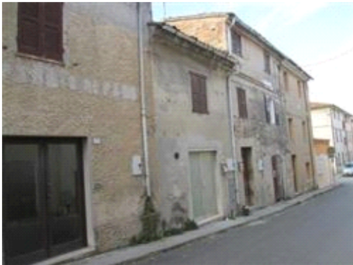
vista esterna fabbricato
