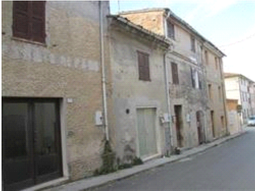
vista esterna fabbricato
