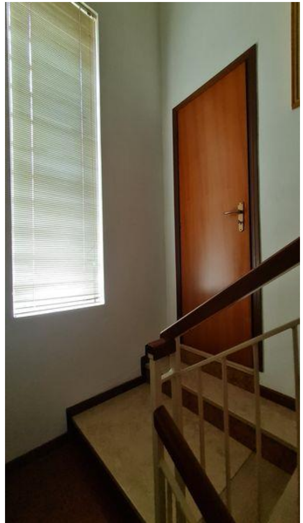
Porta accesso piano ammezzato
