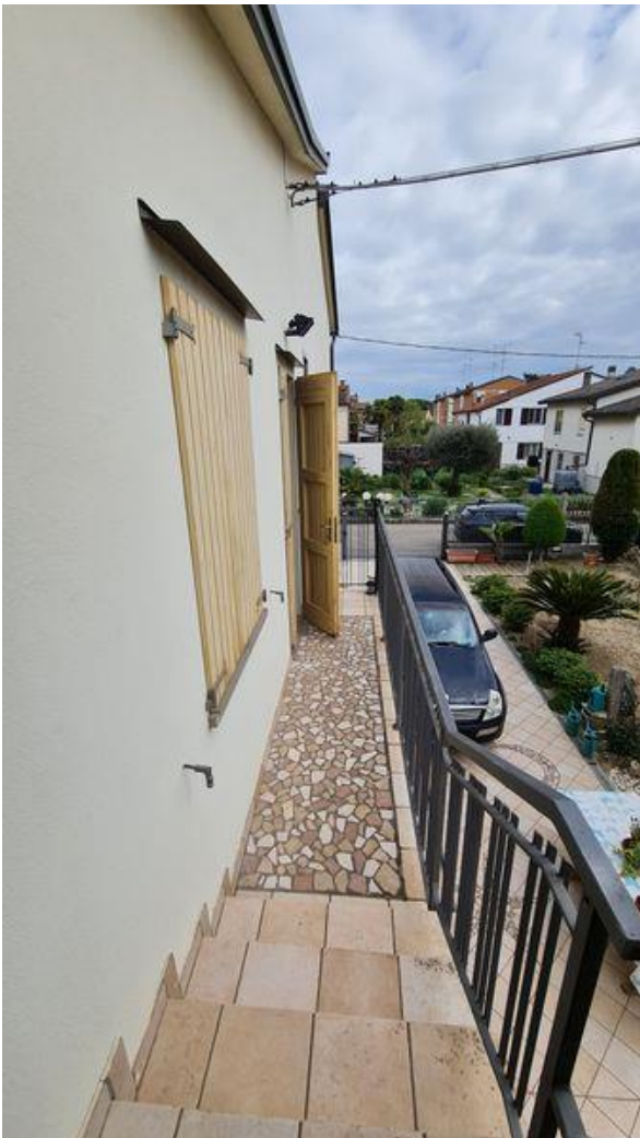
Balcone che dà accesso al terrazzo (piano ammezzato)
