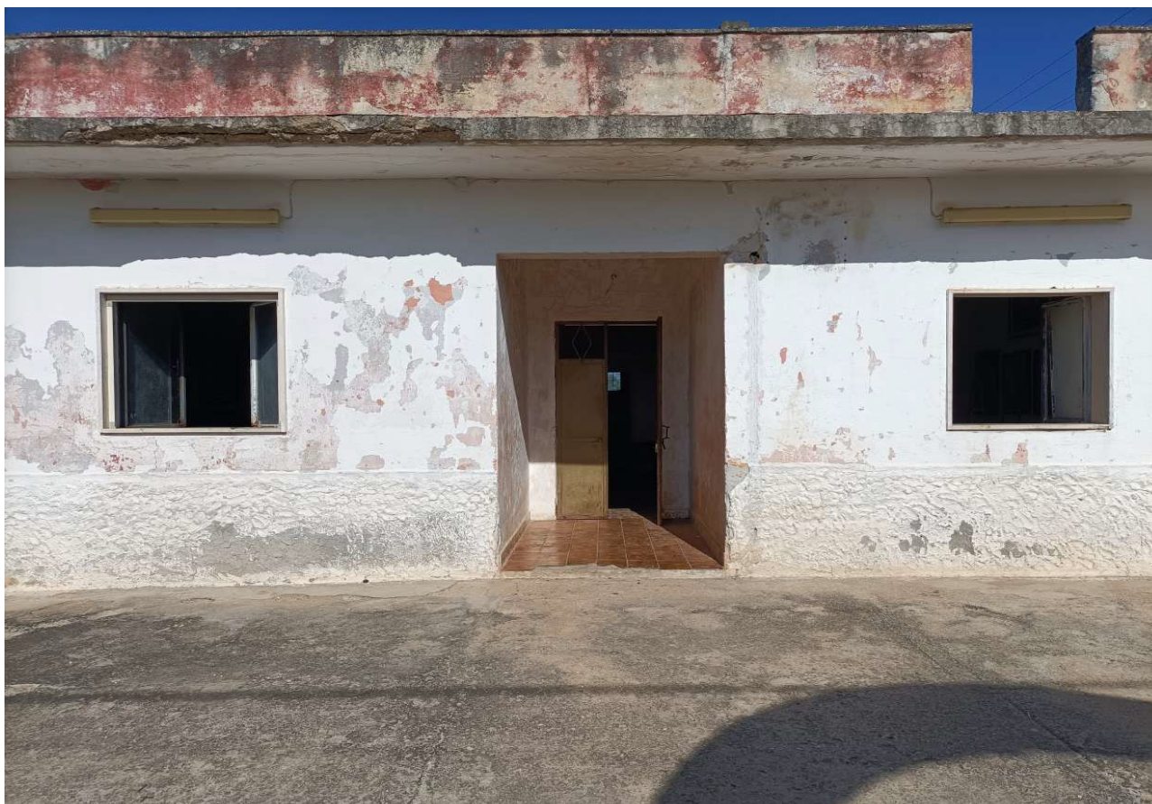
Foto 2 – Vista ingresso immobile
