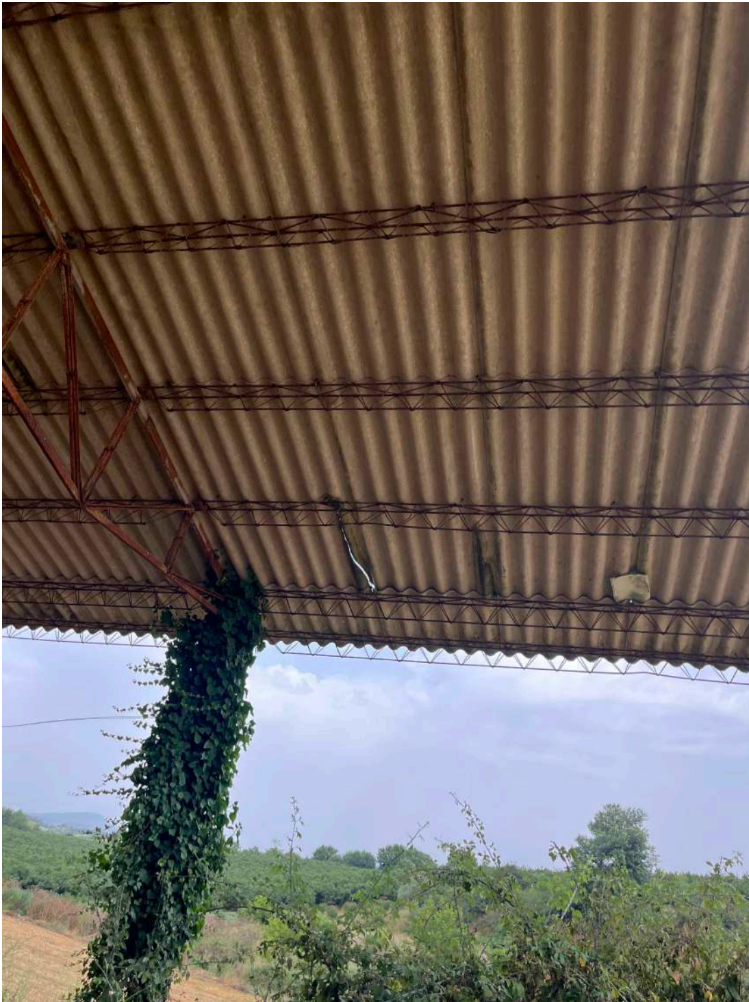
Foto 17 Annesso Agricolo censito al NCT al foglio 21 particella 458
