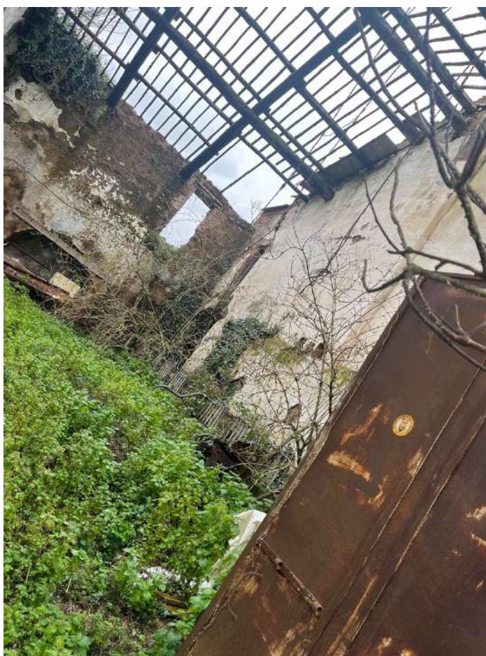
Foto 22-23 Annesso Agricolo censito al NCT al foglio 21 particella 462
