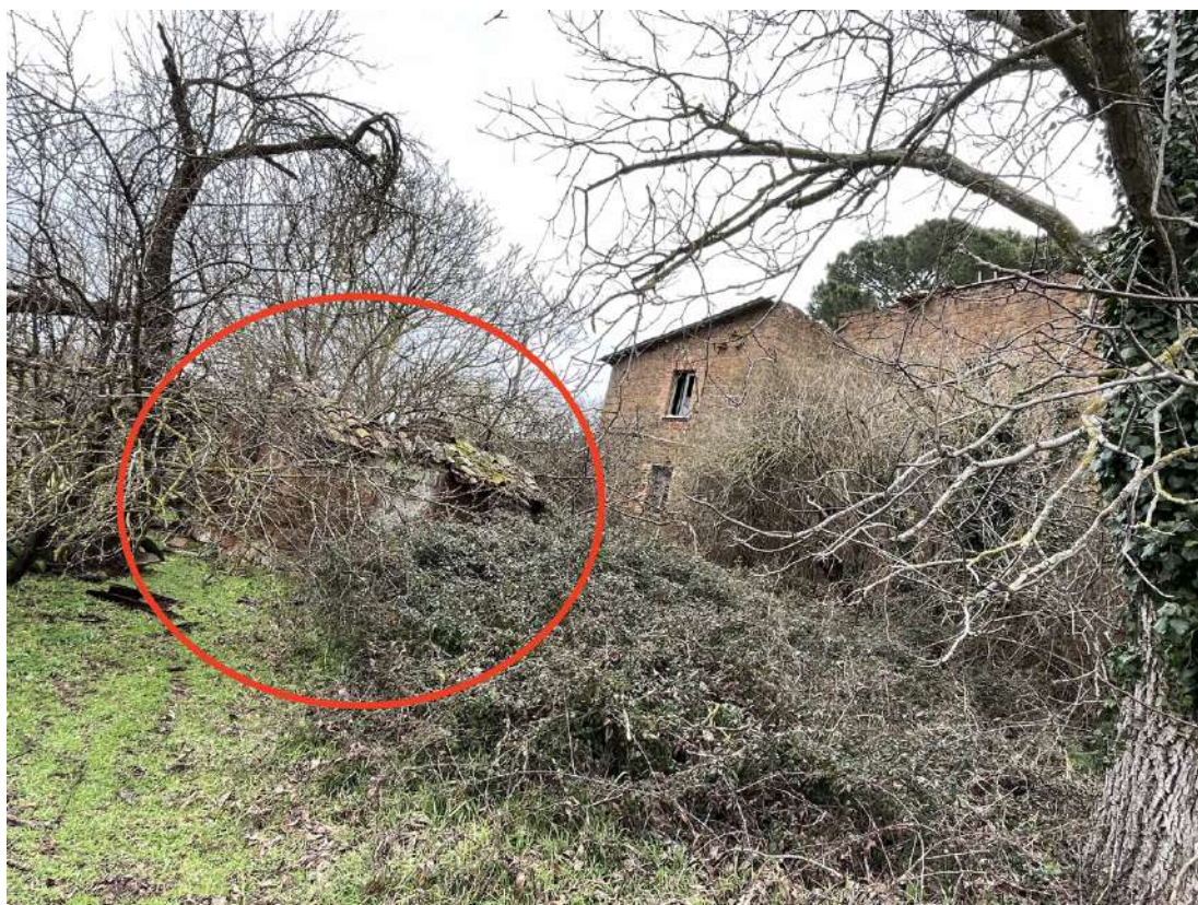
Foto 25 Annesso Agricolo censito al NCT al foglio 21 particella 461
