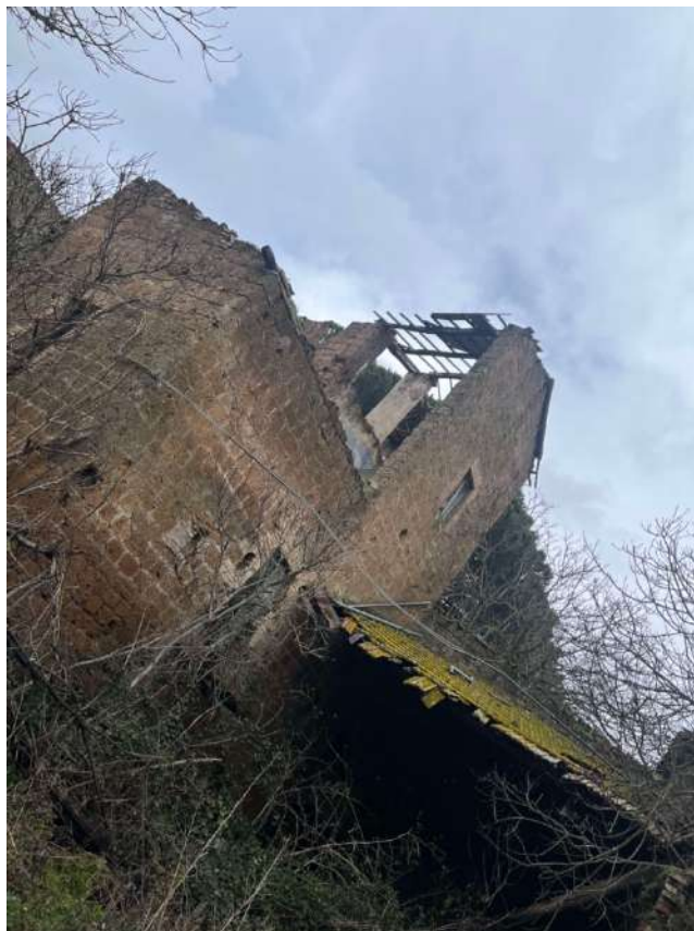
Foto 24 Annesso Agricolo censito al NCT al foglio 21 particella 462
