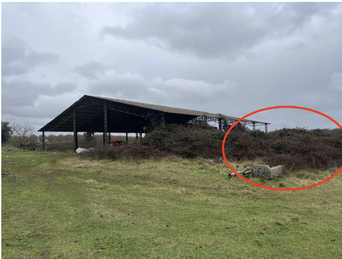
Foto 26 Annesso Agricolo censito al NCT al foglio 21 particella 460
