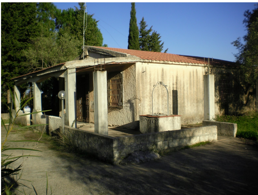
Foto 02: Vista prospetto Sud- Ovest
