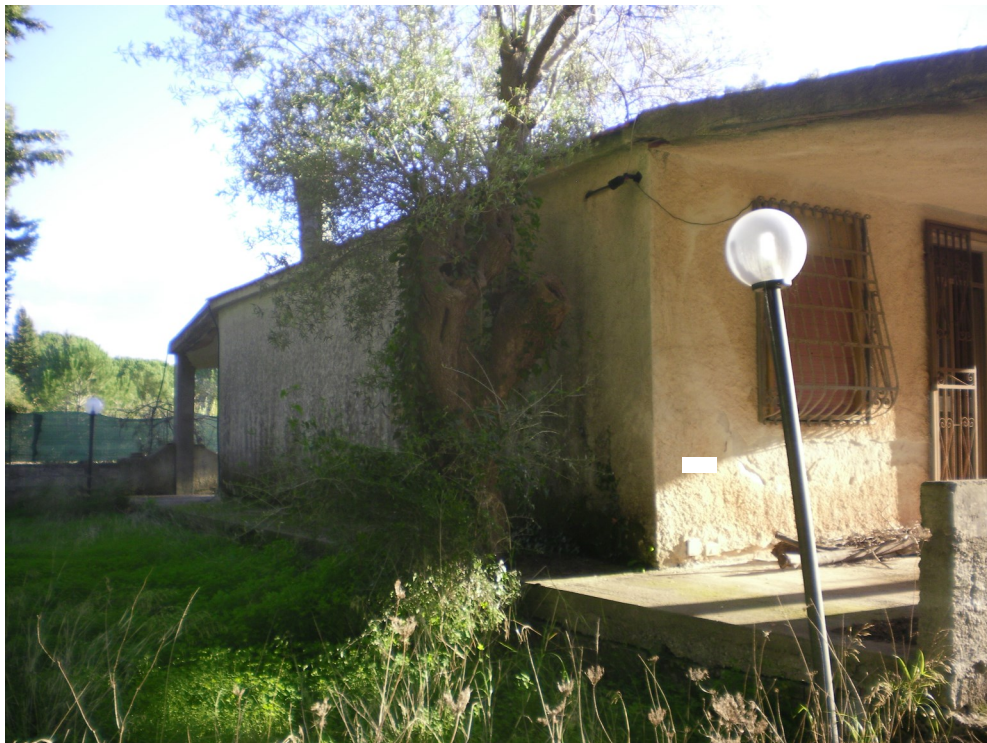
Foto 04: Vista prospetto Nord
