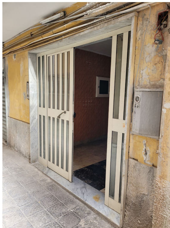
Vista cancello di accesso allo stabile
