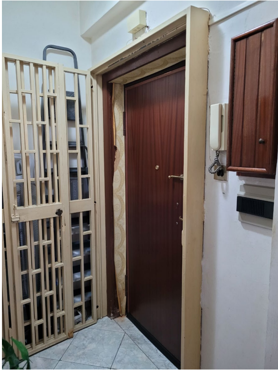
Vista vano di accesso - locale ingresso
