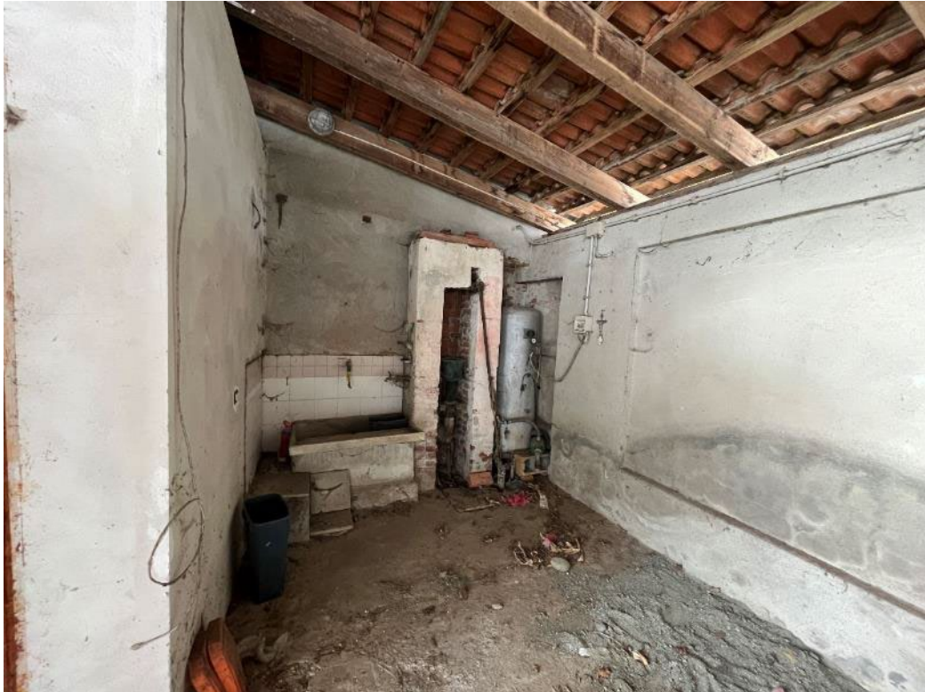
Figura 49: vista del bene 4 (prima porzione)
