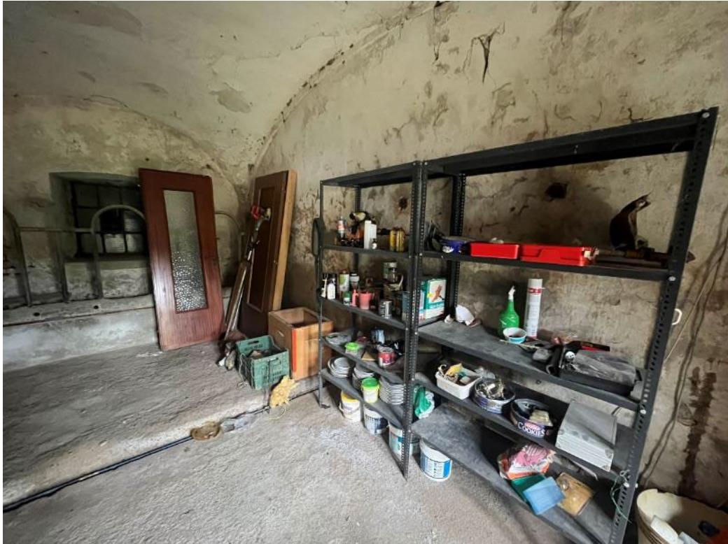
Figura 41: vista del piano terreno del bene 3
