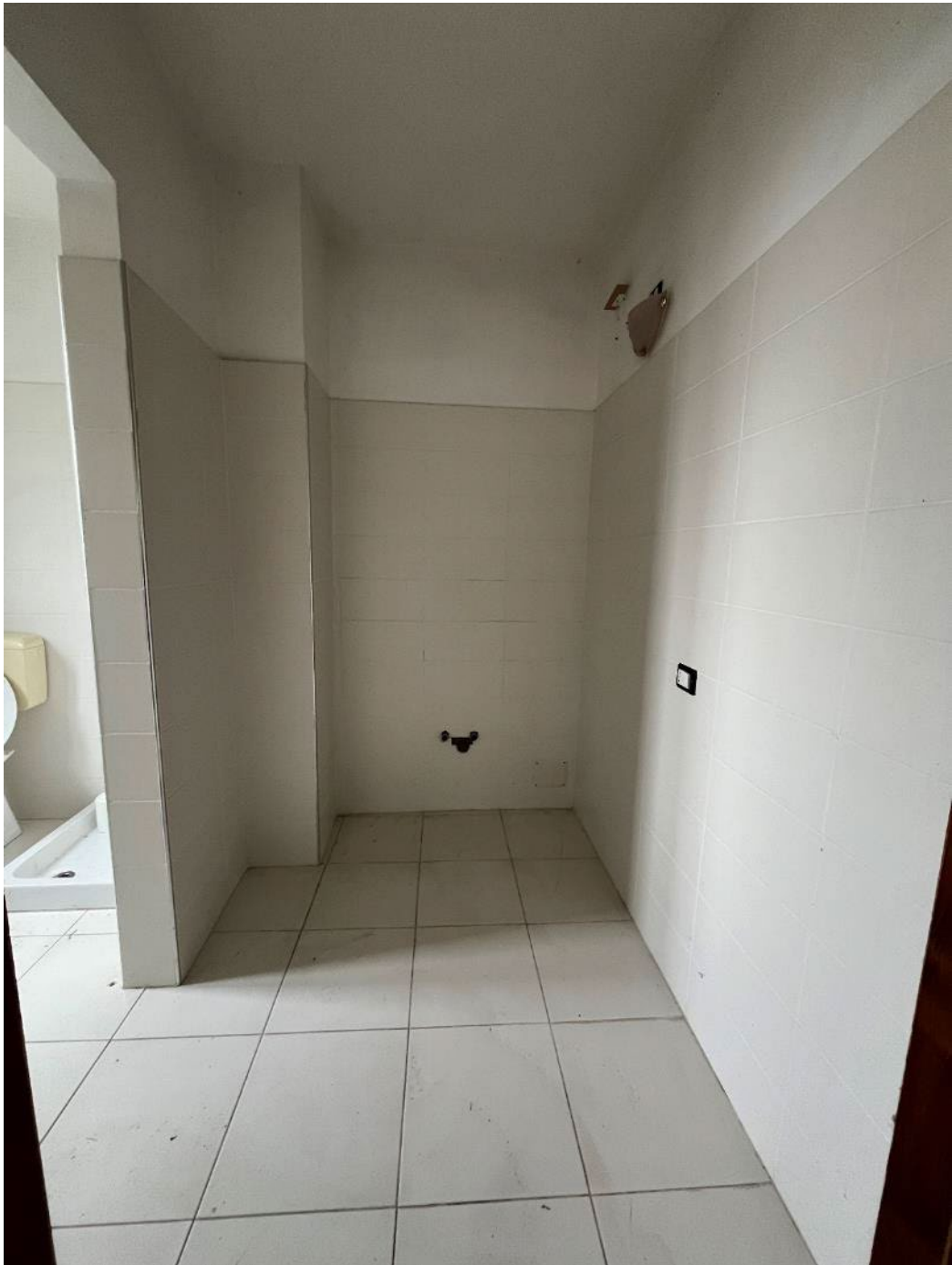
Figura 51: vista del bene 4 (prima porzione)
