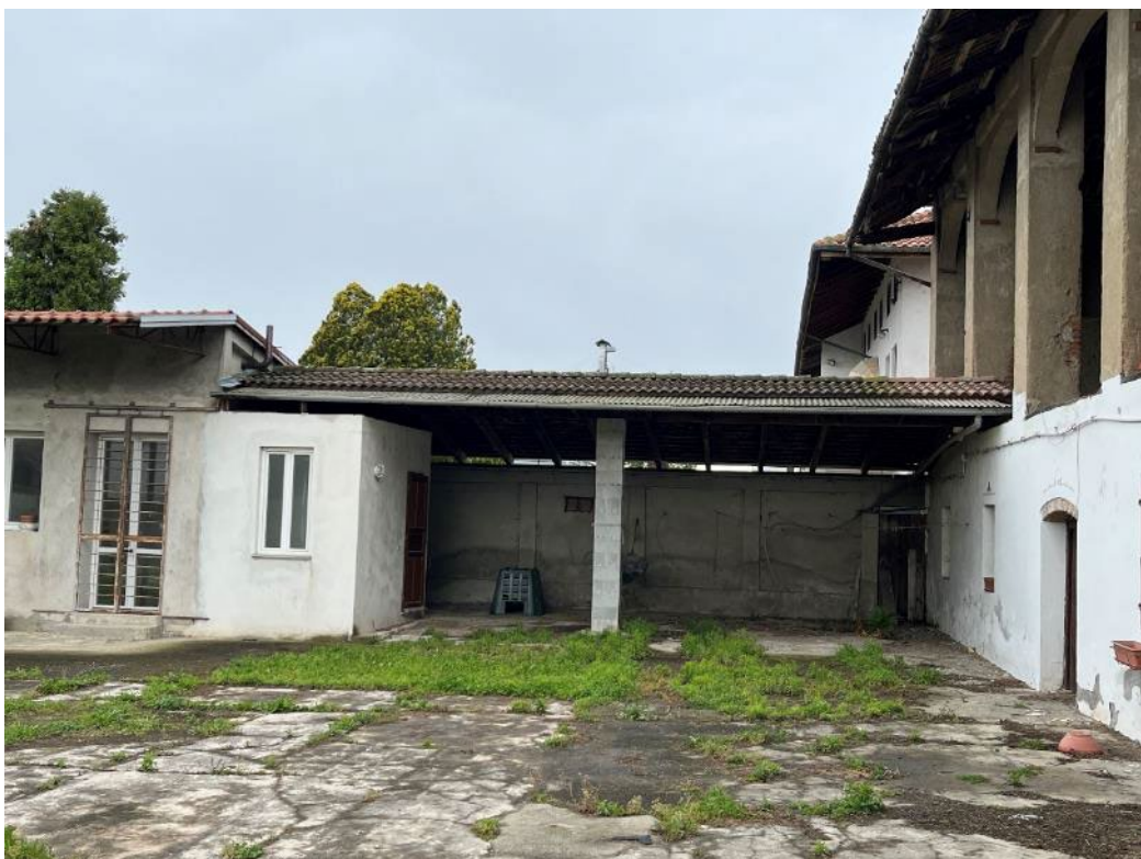
Figura 12: vista del bene 2 del bene 4 (prima e quinta porzione)
