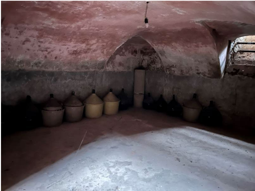
Figura 35: vista della cantina al piano interrato del bene 1
