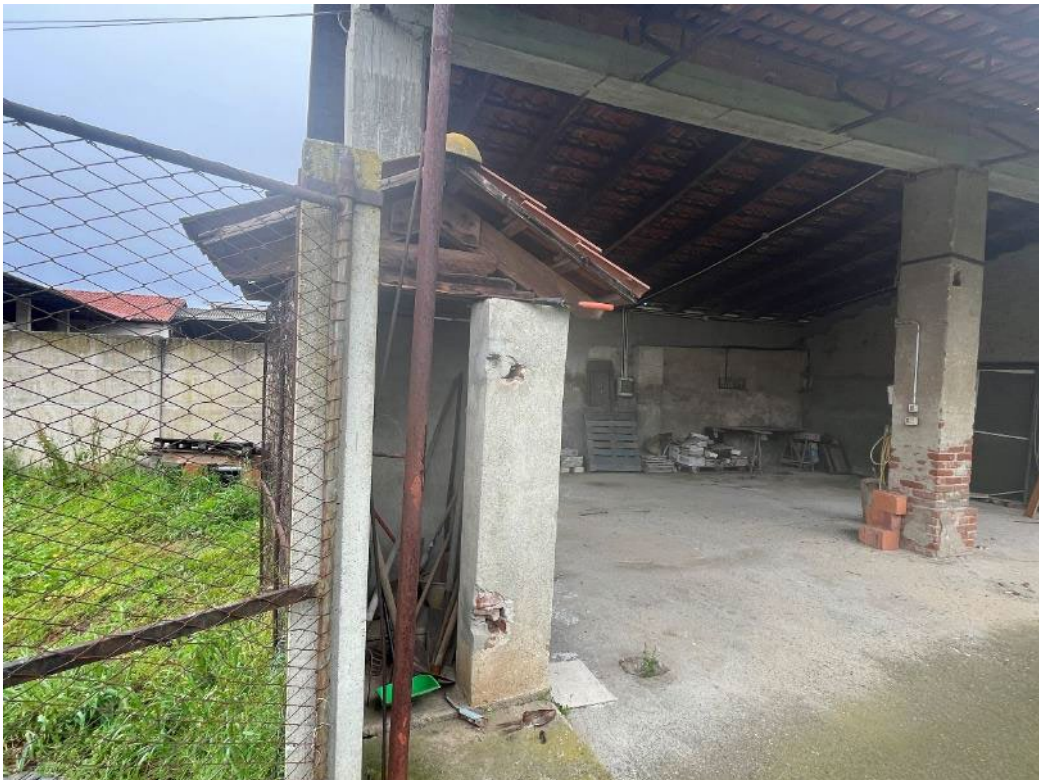
Figura 54: vista del bene 4 (seconda porzione)
