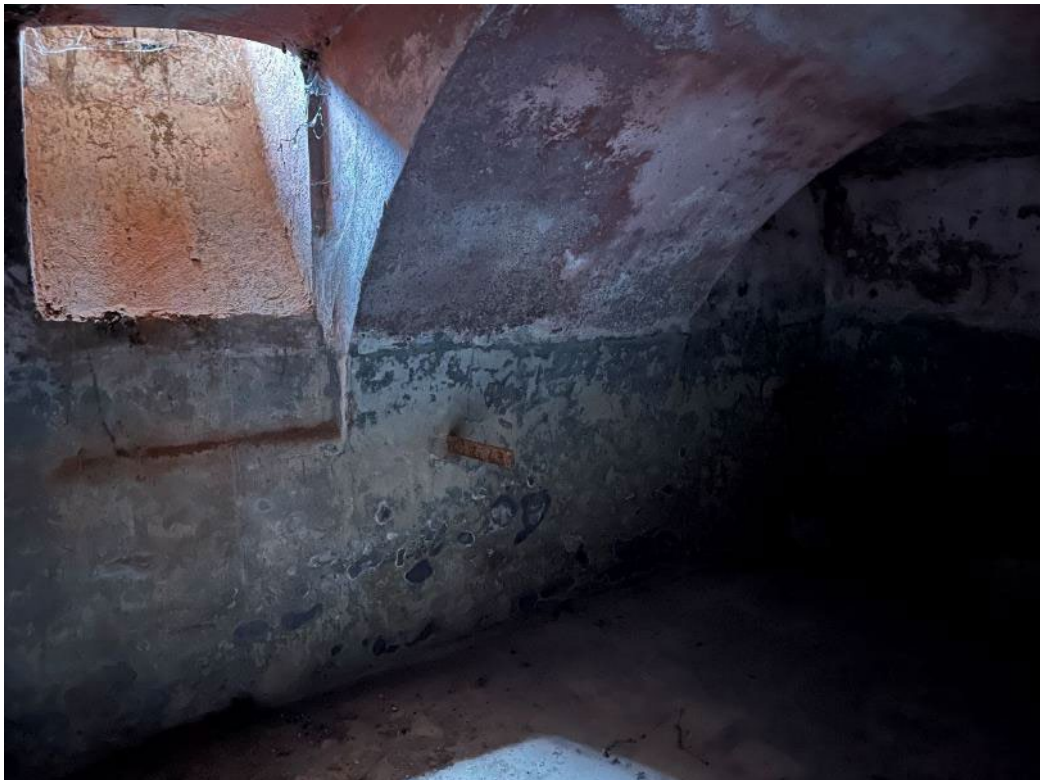
Figura 36: vista della cantina al piano interrato del bene 1
