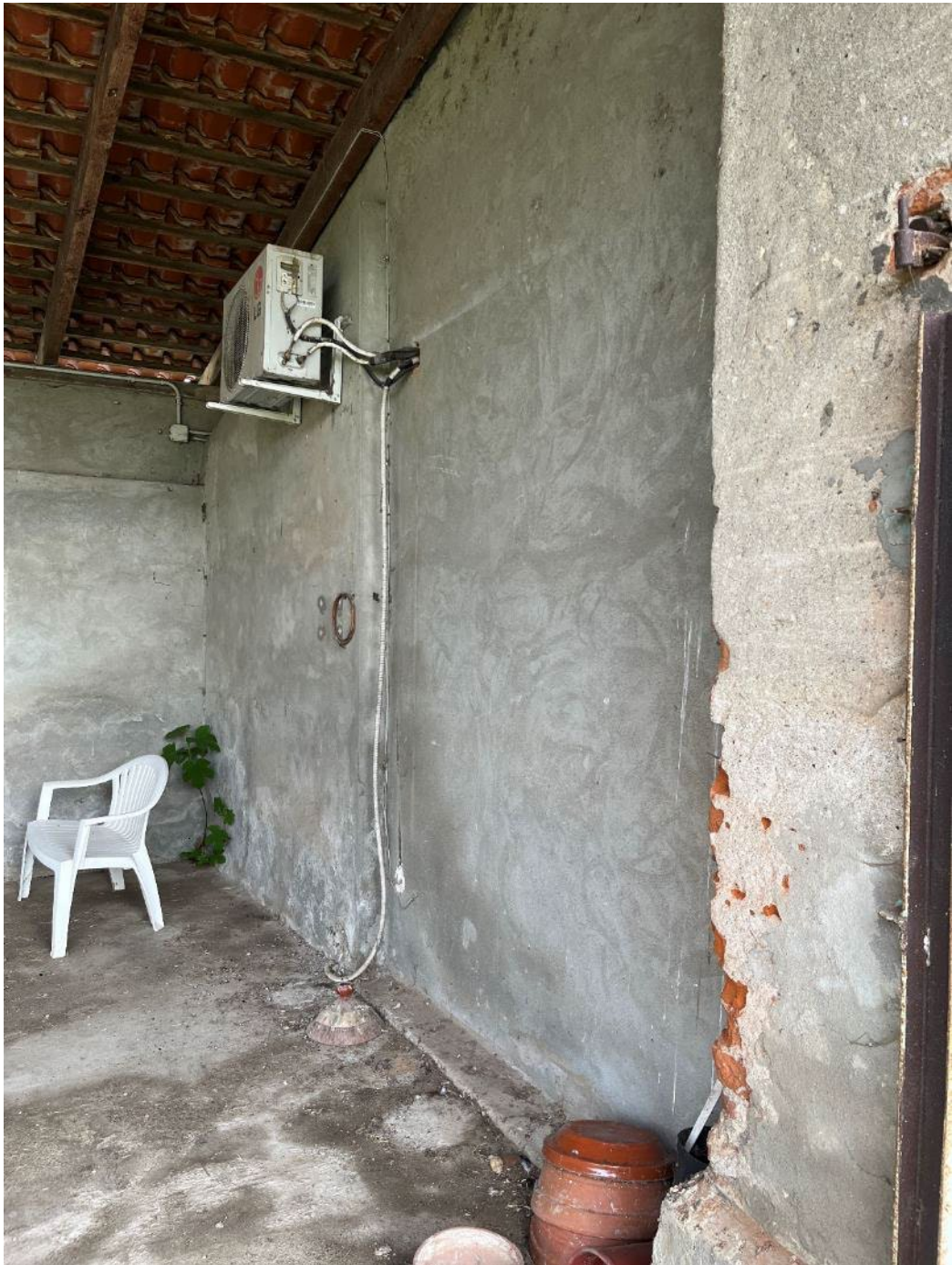
Figura 52: vista del bene 4 (seconda porzione)
