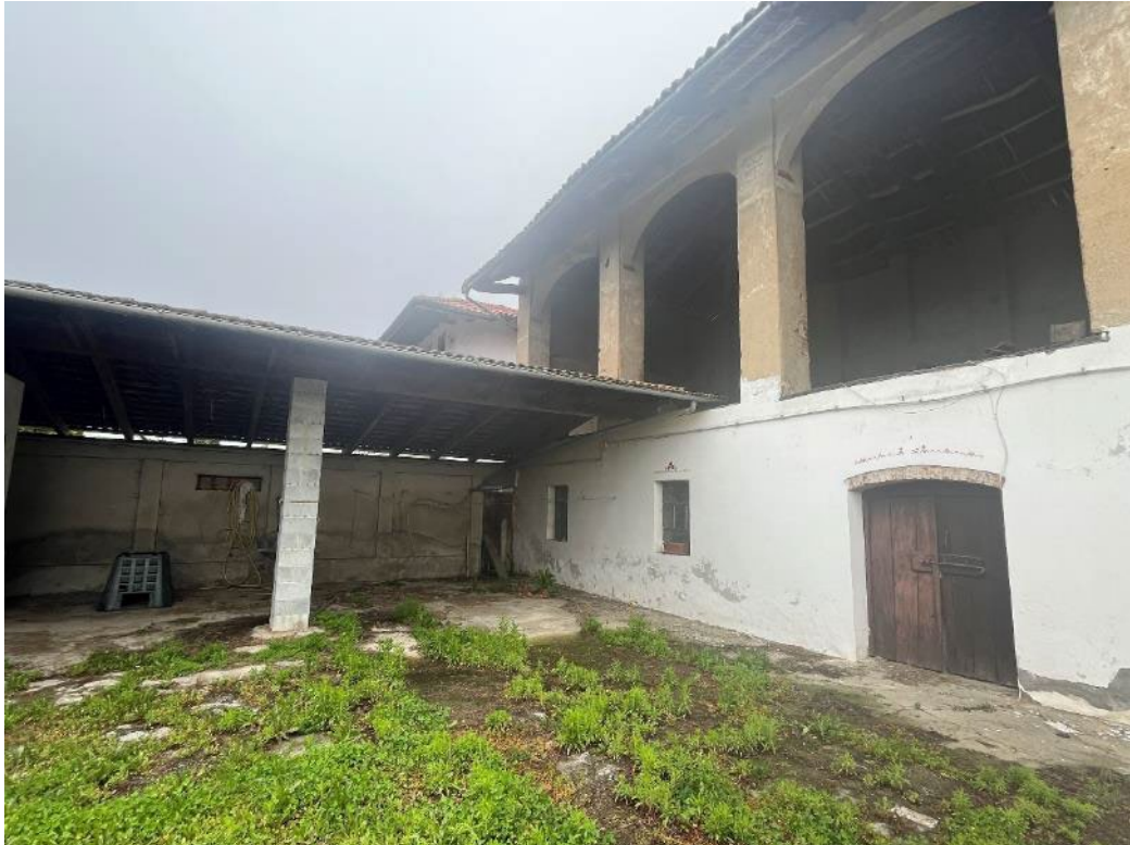
Figura 11: vista del bene 3 del bene 4 (prima e quinta porzione), si noti al centro della ripresa la porta bloccata con delle assi e che conduce allo scolatoio esterno
