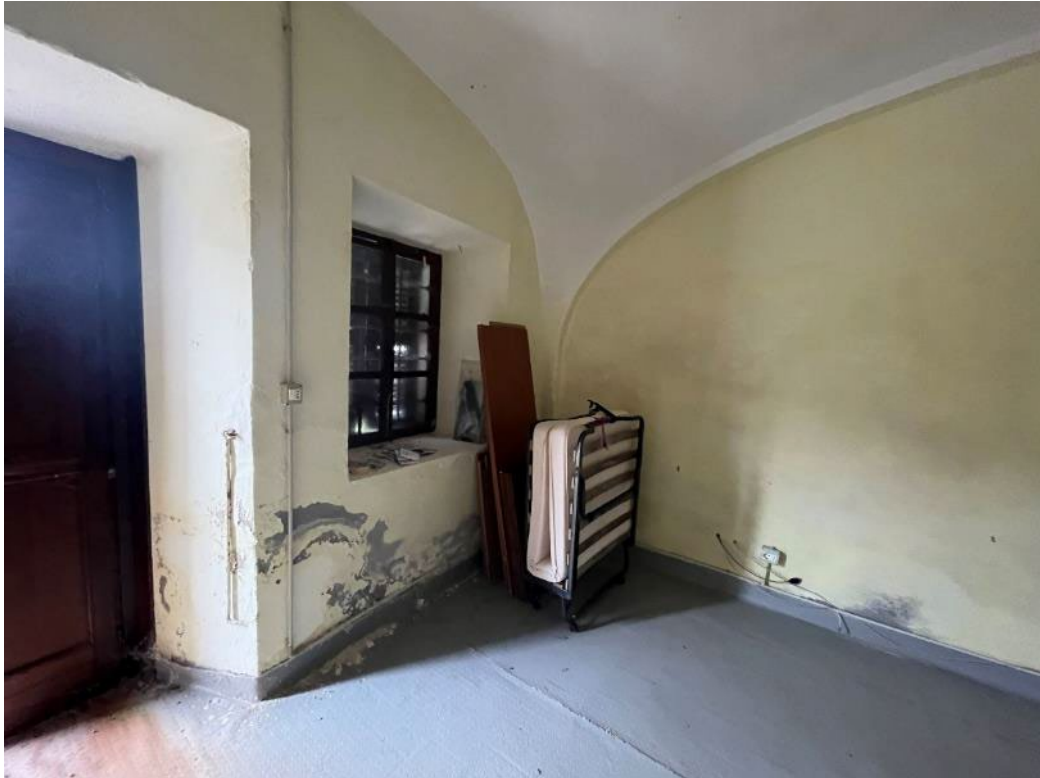
Figura 39: vista del piano terreno del bene 3
