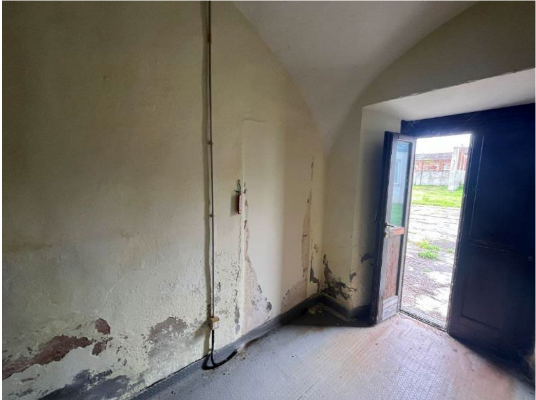
Figura 37: vista del piano terreno del bene 3
