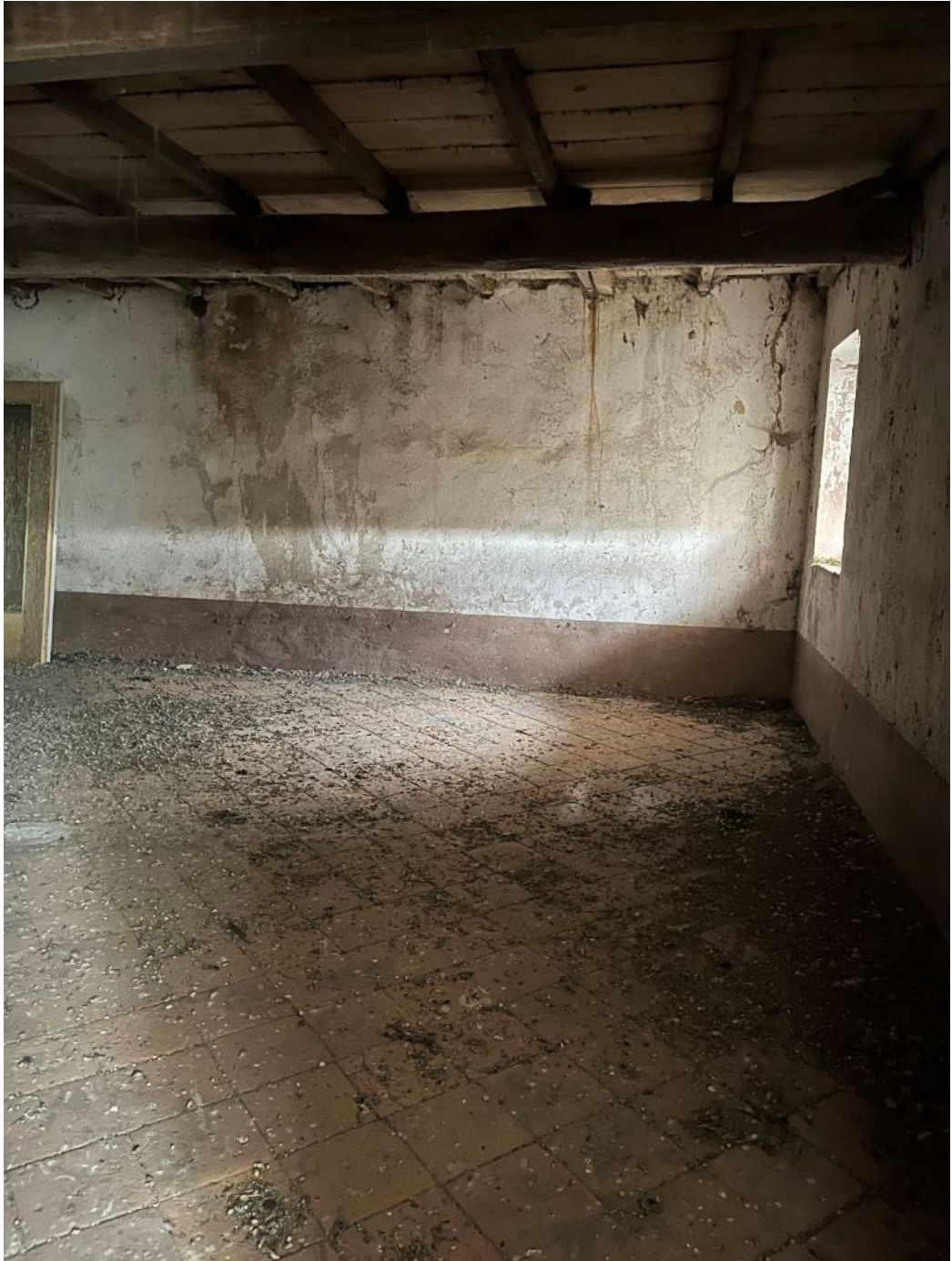
Figura 44: vista del piano primo del bene 3
