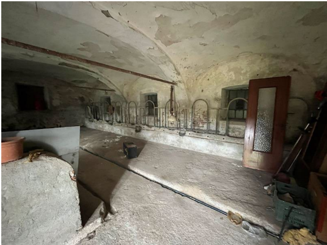
Figura 42: vista del piano terreno del bene 3
