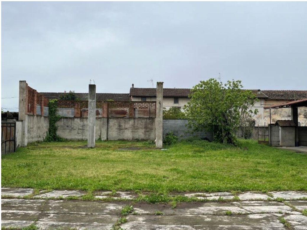
Figura 18: vista del bene 4 (terza e quarta porzione)
