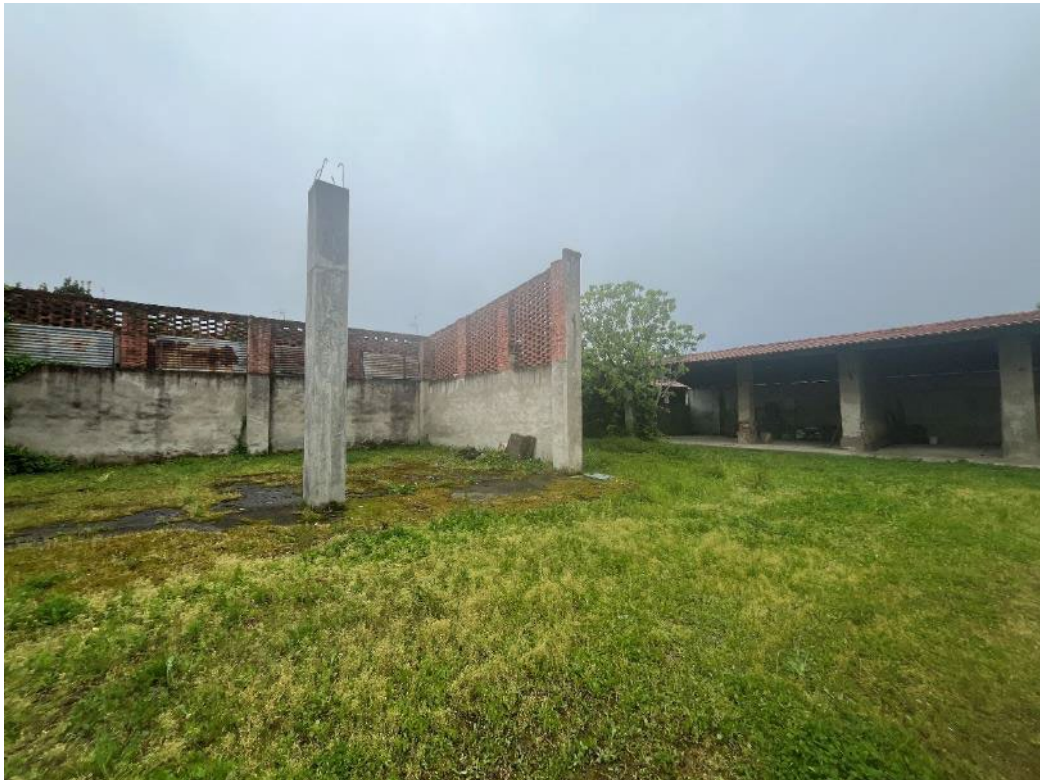
Figura 19: vista del bene 4 (seconda, terza e quarta porzione)
