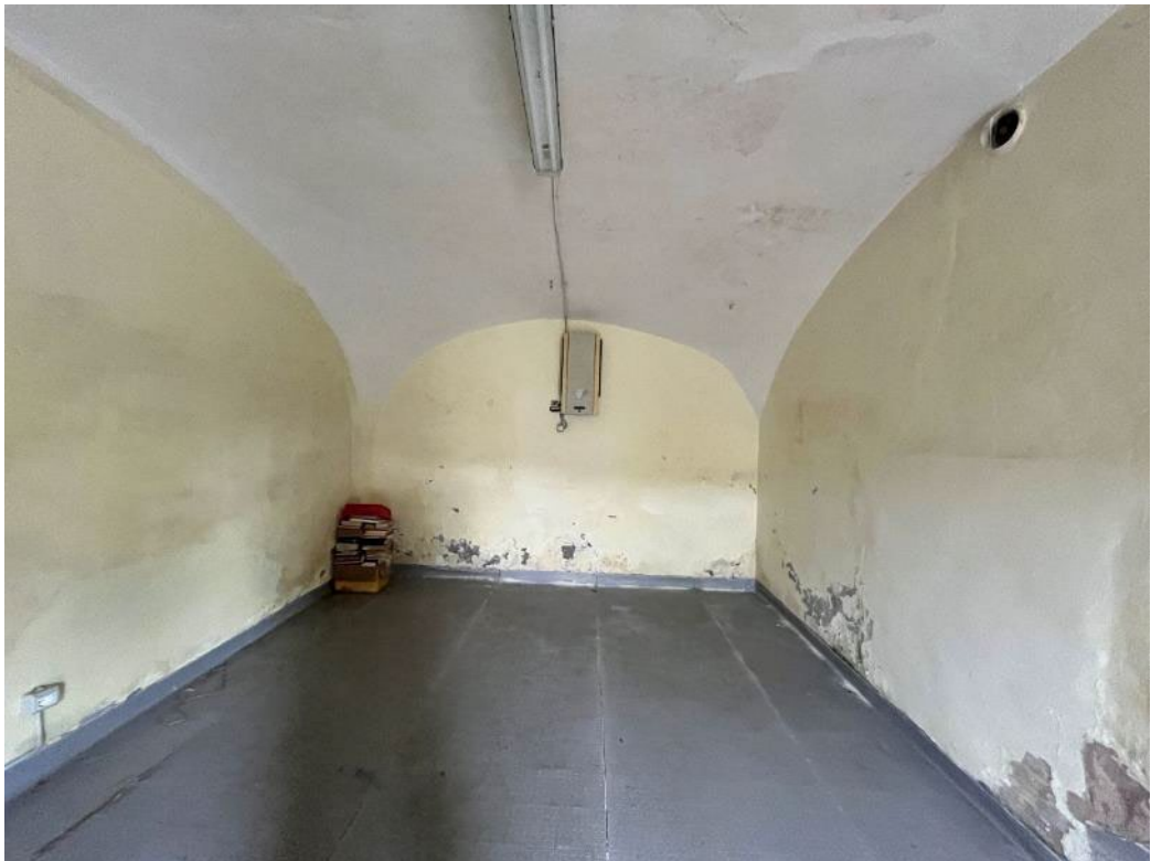
Figura 38: vista del piano terreno del bene 3
