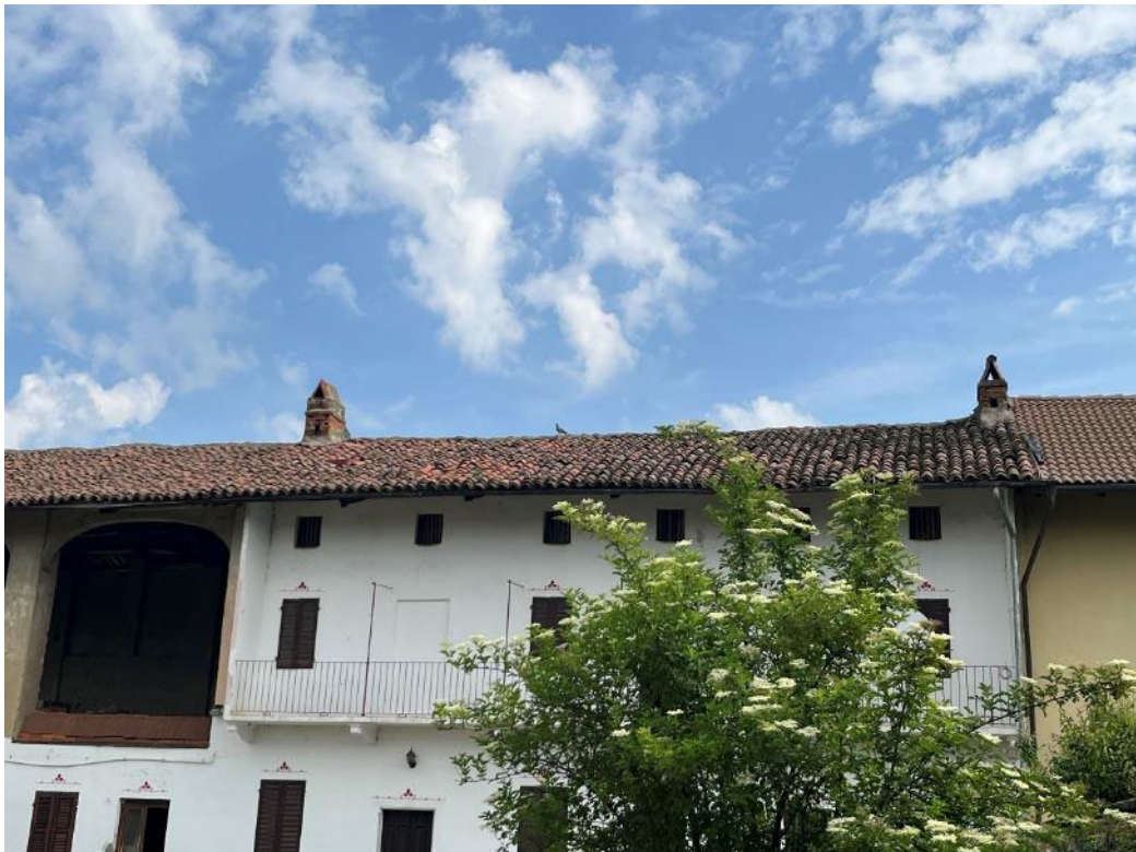
Figura 8: dettaglio del manto di copertura
