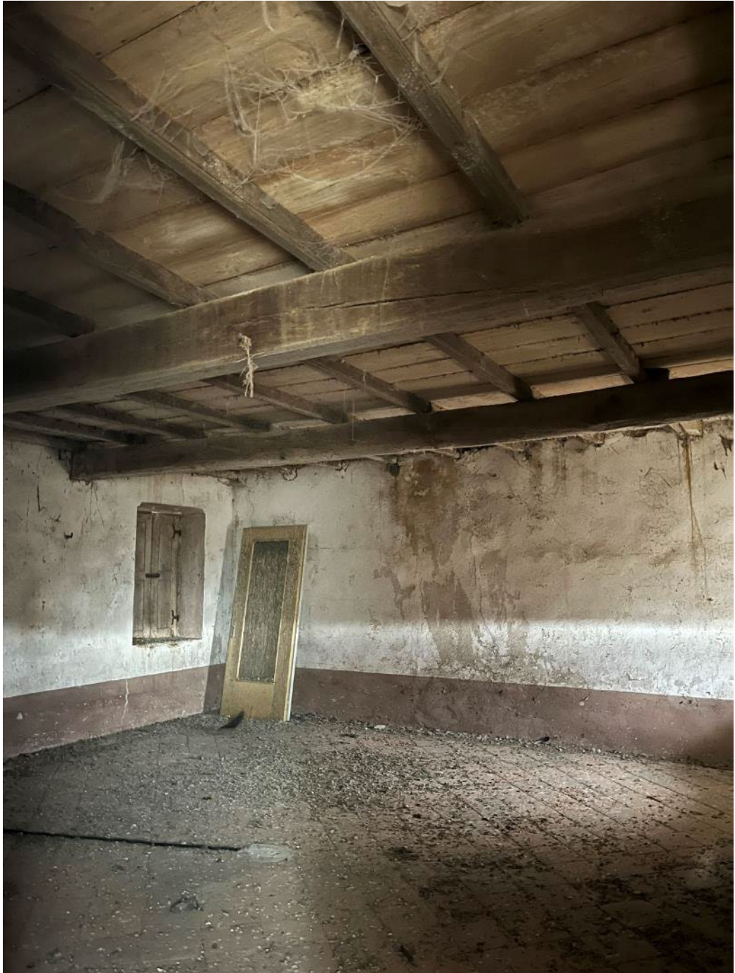
Figura 45: vista del piano primo del bene 3
