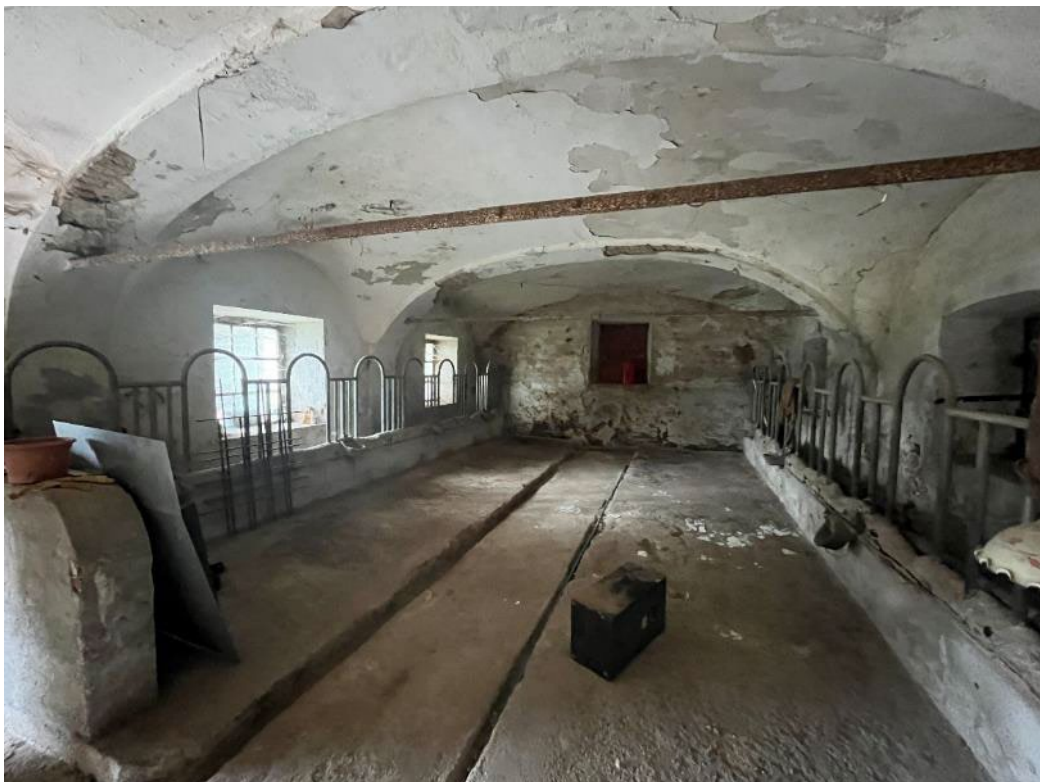
Figura 40: vista del piano terreno del bene 3
