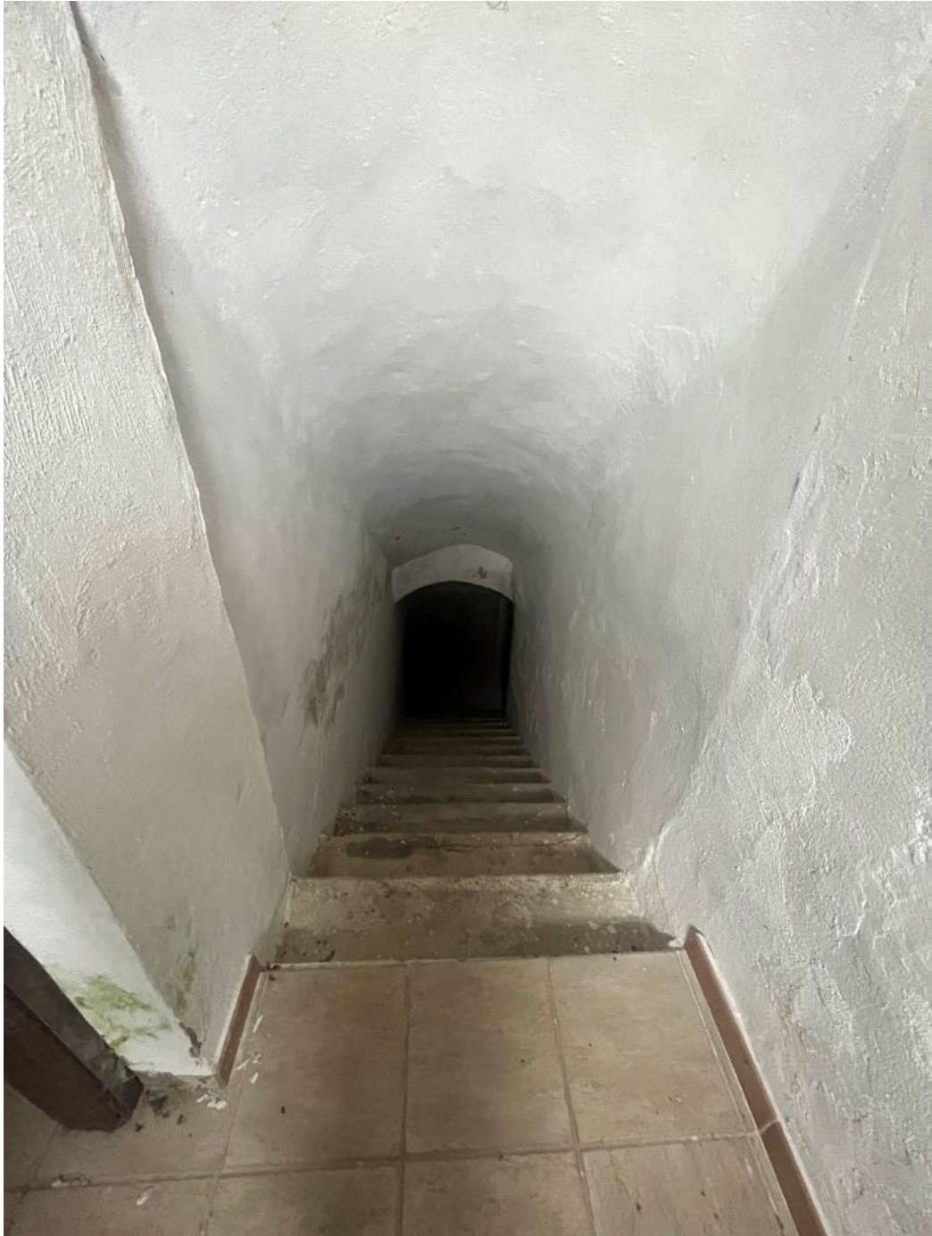
Figura 34: vista della scala verso il piano interrato del bene 1
