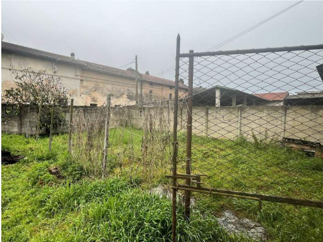
Figura 17: vista dell'area verde e della recinzione perimetrale
