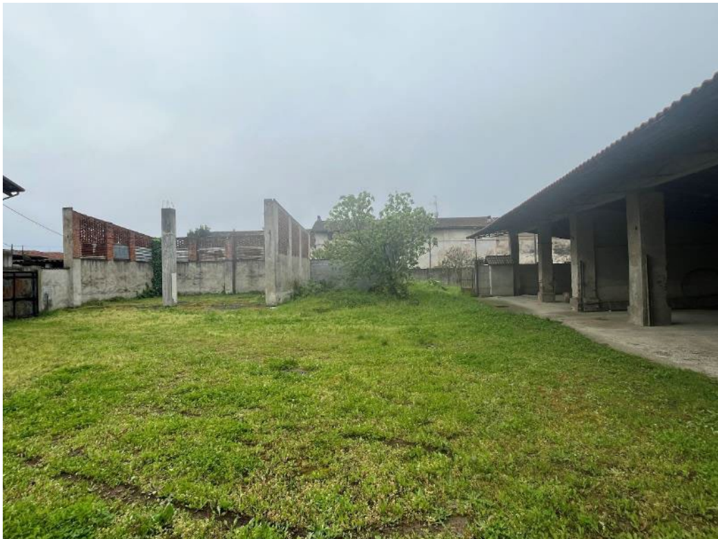
Figura 16: vista del bene 4 (seconda, terza e quarta porzione)
