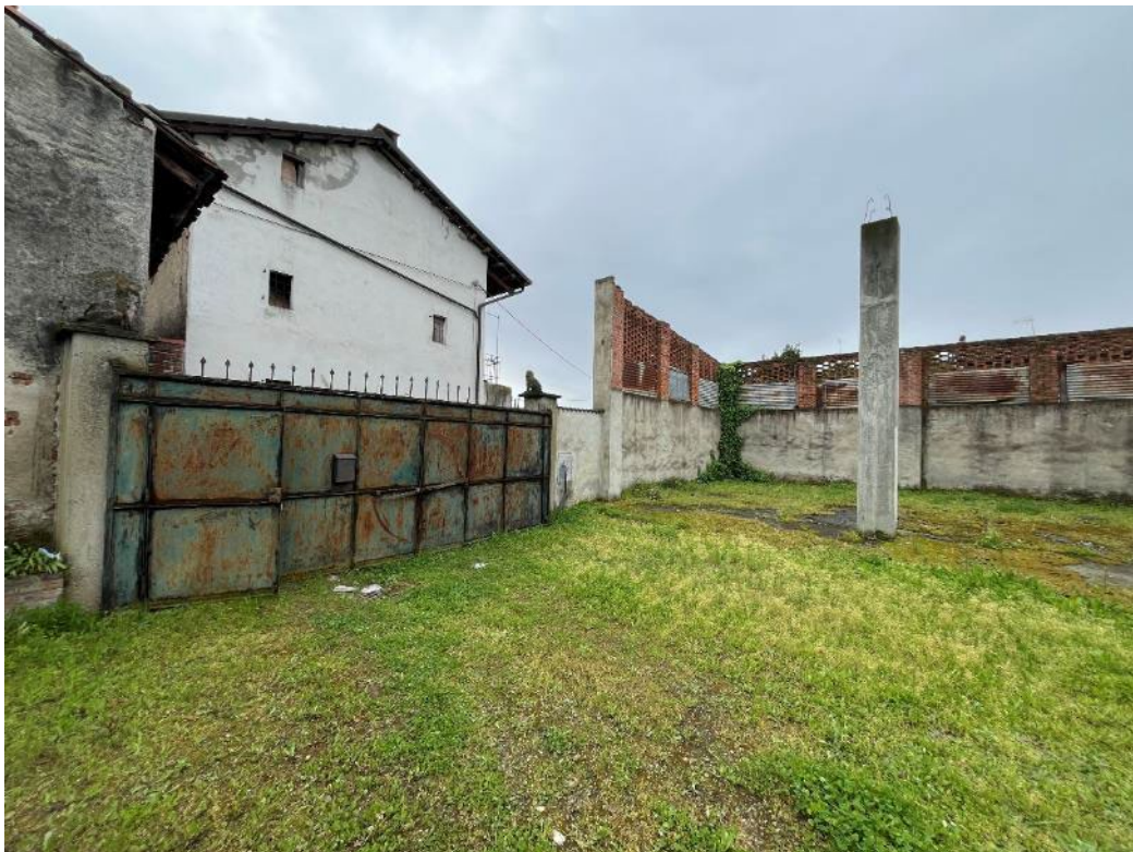
Figura 2: vista dell'accesso pedonale e carroia
