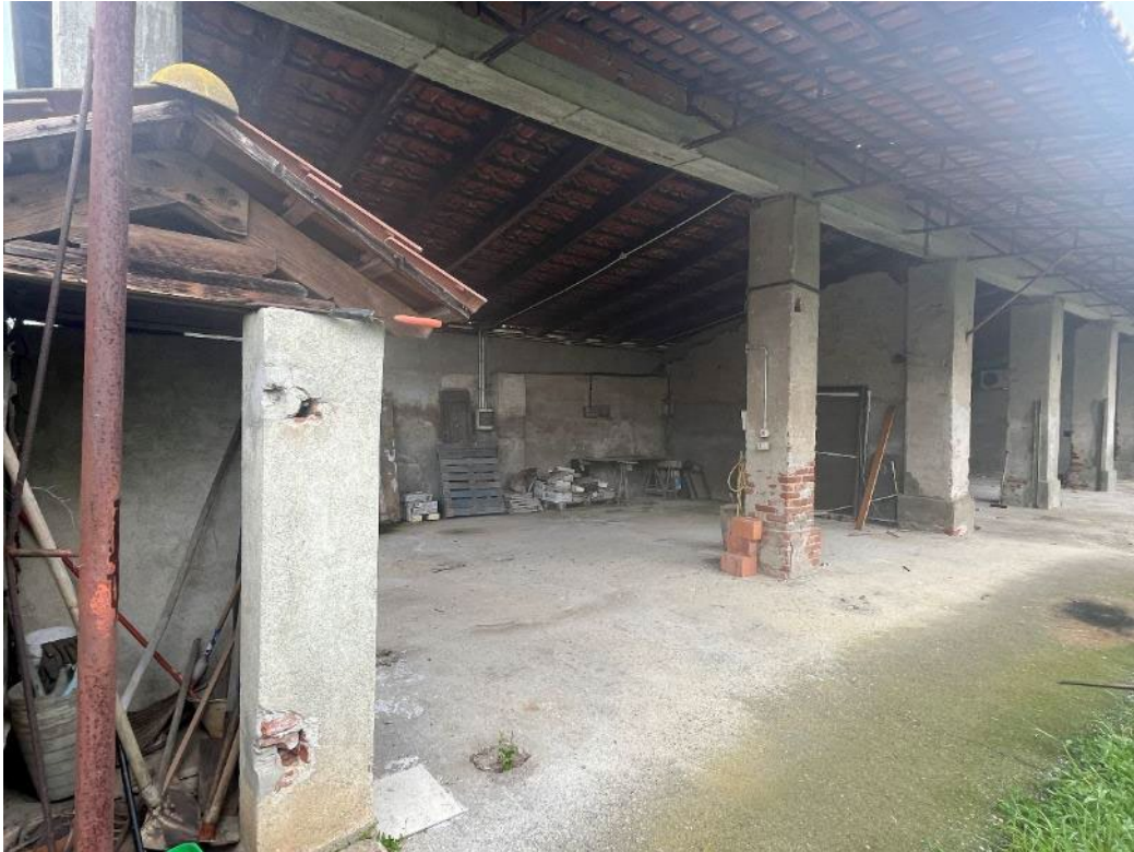
Figura 53: vista del bene 4 (seconda porzione)
