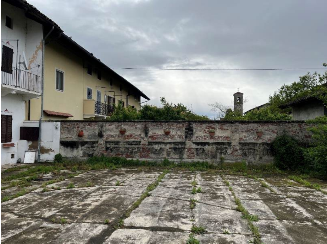
Figura 5: vista del muro di cinta a sud-ovest del lotto
