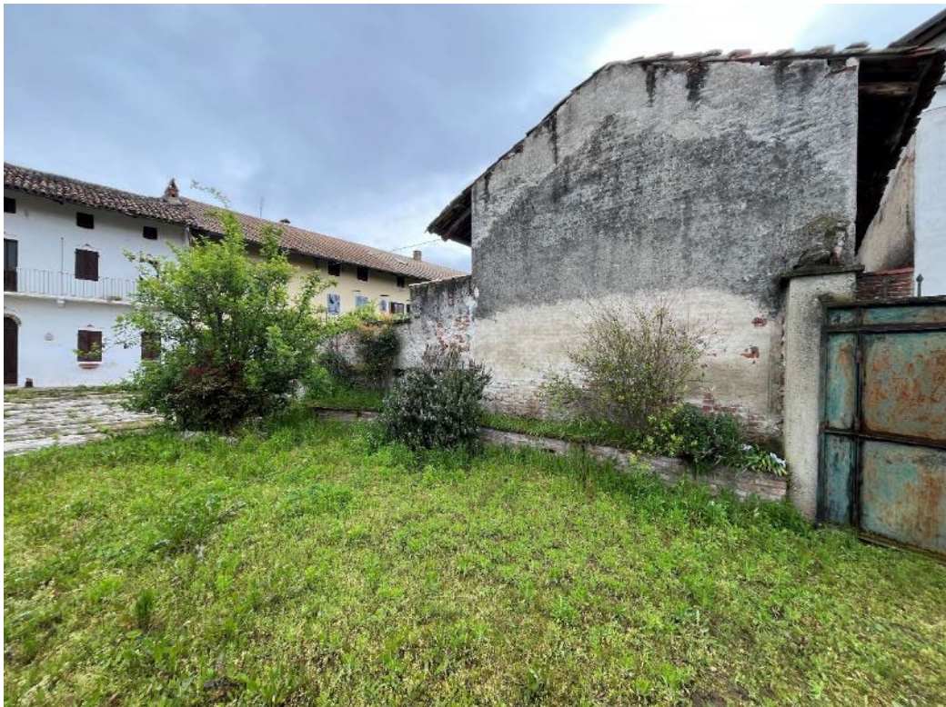
Figura 4: vista sul fabbricato posto lungo il confine sud-ovest
