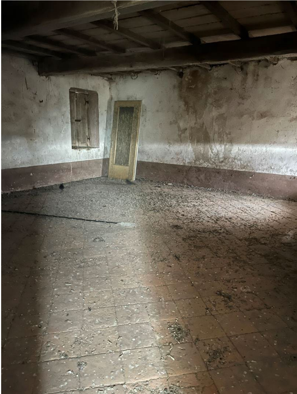
Figura 43: vista del piano primo del bene 3
