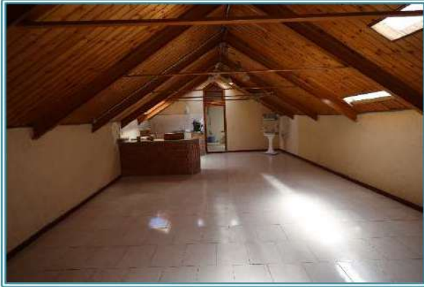
Figura 26 Soffitta1 (Piano Sottotetto)
