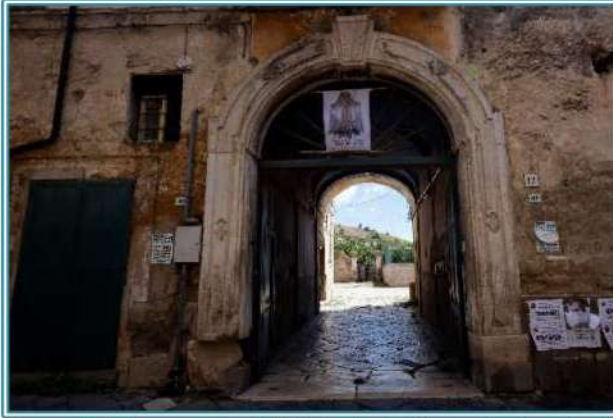
Figura 8 Vista accesso al fabbricato da Via Santa Margherita
