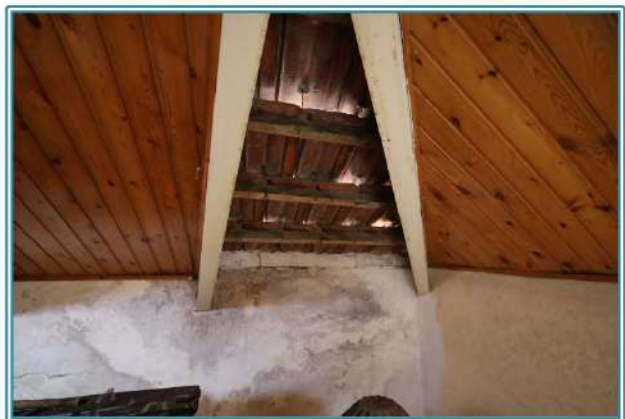
Figura 31 Dettaglio tetto di copertura
