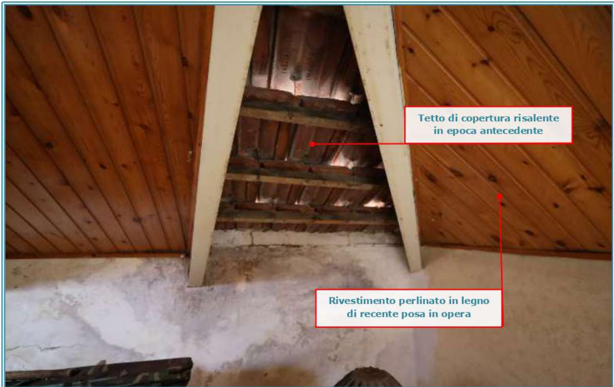
Figura 40 Dettaglio tetto di copertura
