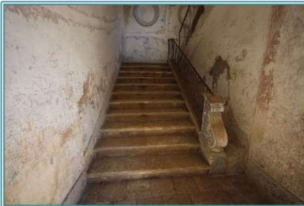
Figura 12 Scala comune che conduce al piano primo
