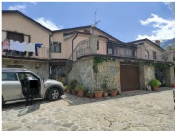
Figura 7: vista da ingresso
