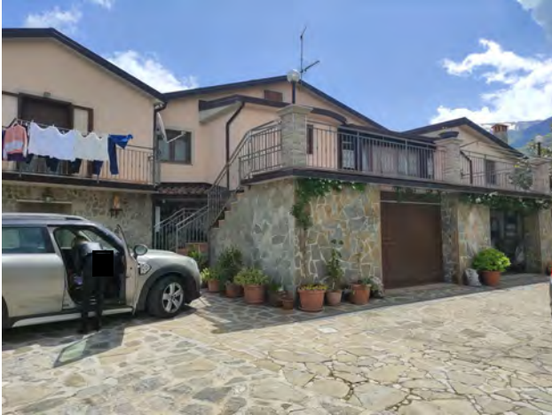
Figura 7: vista da ingresso
