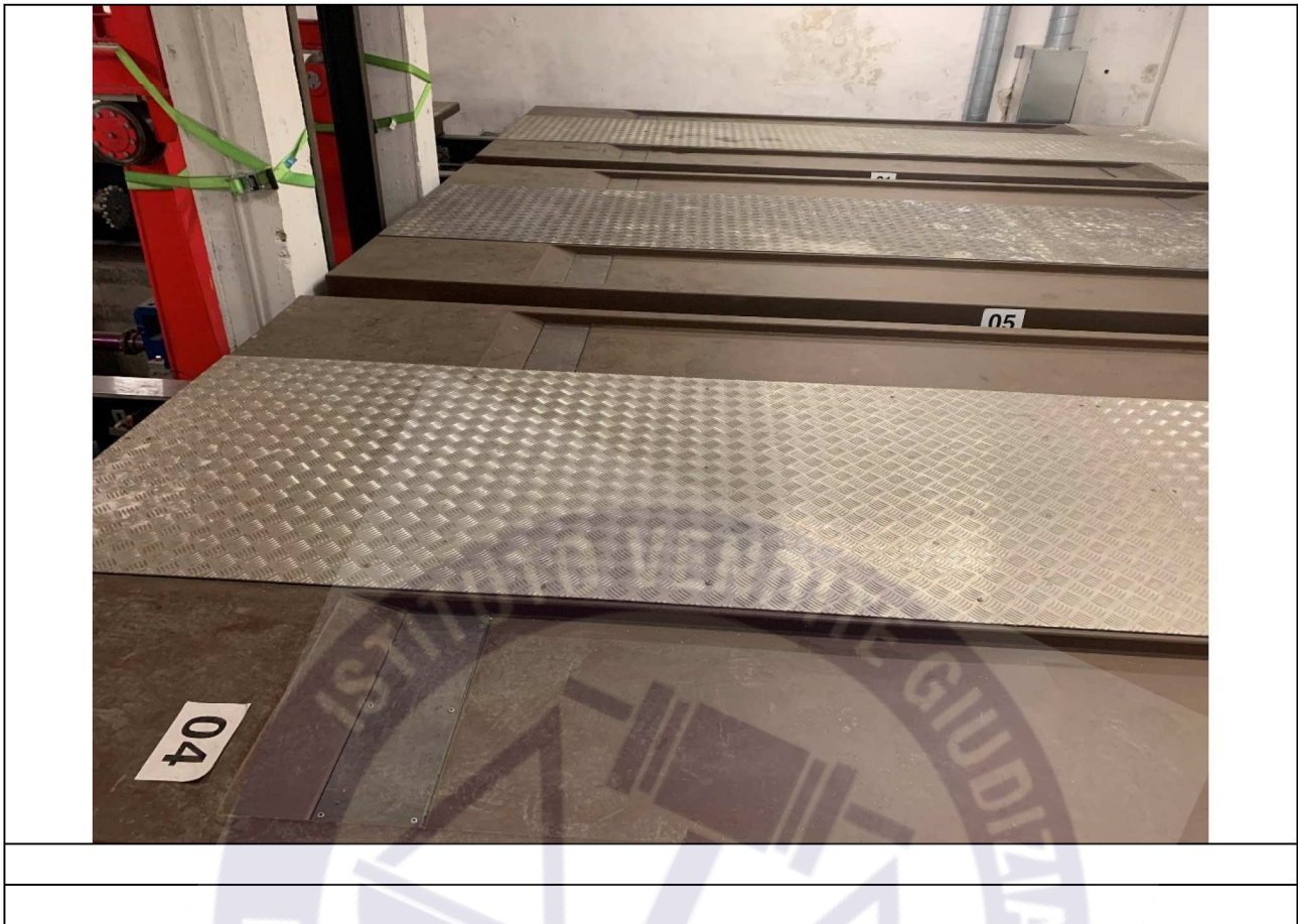
Foto Lotti 1-2-3- Posti auto autorimessa collettiva posta al piano interrato con piattaforma elevatrice meccanizzata al piano terra- proprietà indivisa
