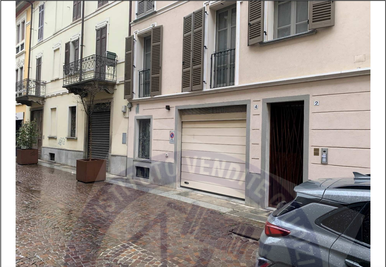
Foto Lotti 1-2-3- Posti auto autorimessa collettiva posta al piano interrato con piattaforma elevatrice meccanizzata al piano terra- proprietà indivisa
