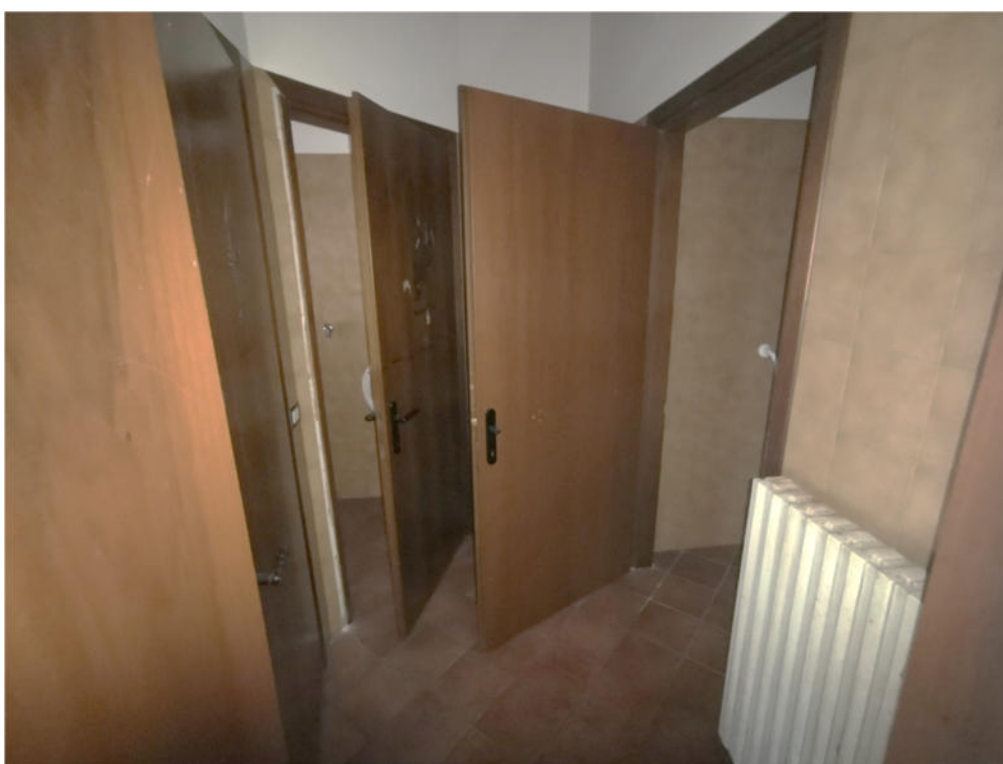
14 – particolare interno mapp. 185 sub.14
