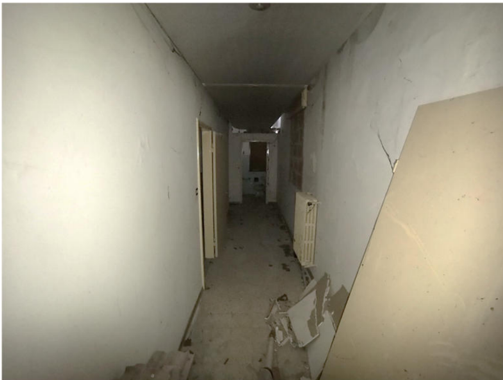
20 – particolare interno mapp. 185 sub.9
