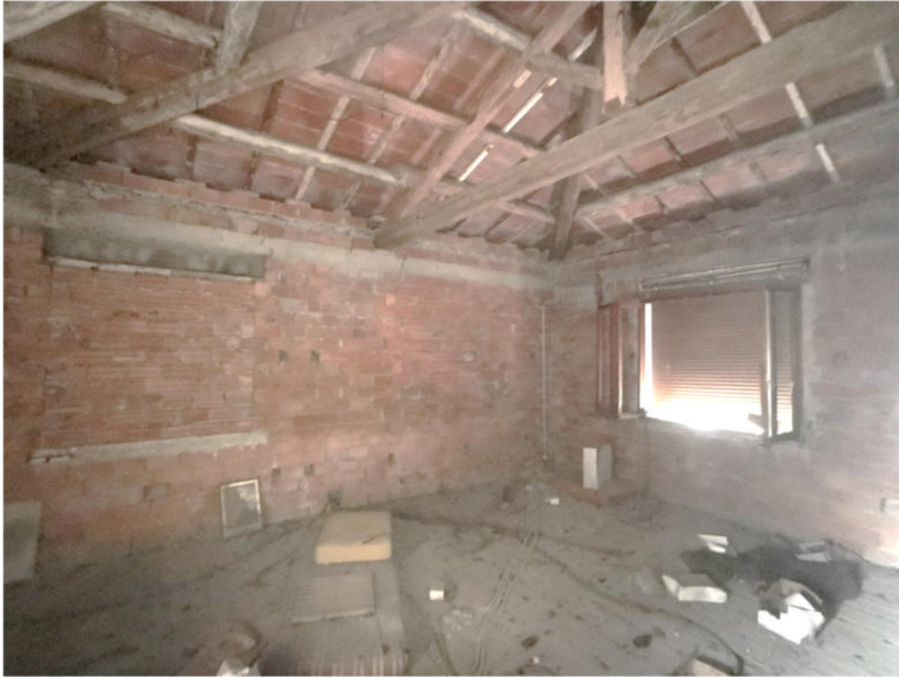
21 – particolare interno mapp. 185 sub.9
