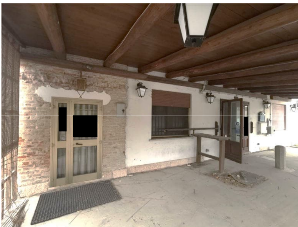
10 – particolare prospetto sud – ingresso mapp. 185 sub.4
