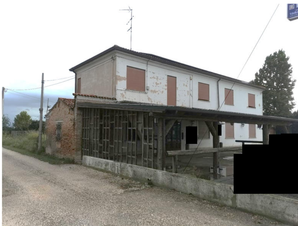
4 – particolare prospetto sud-ovest mapp. 185
