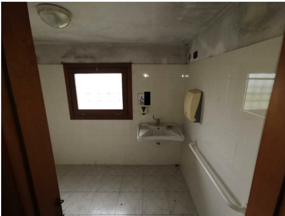
17 – particolare interno mapp. 185 sub.15
