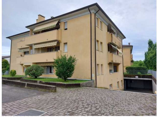
Ingresso autorimessa lato est
