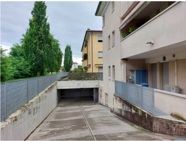
Ingresso autorimessa lato ovest
