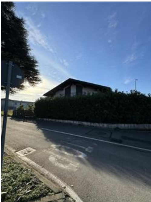
Villetta - fronte Via G. Mazzini
