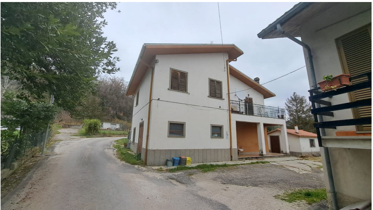
Vedute esterne del fabbricato e delle aree di accesso
