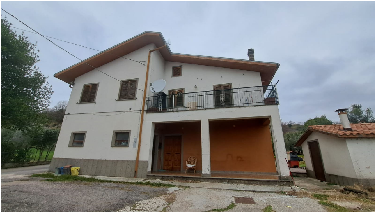
Vedute esterne del fabbricato e delle aree di accesso
