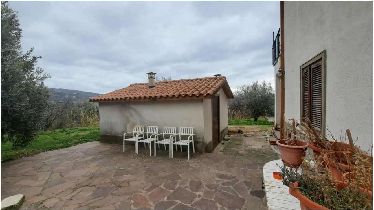
Vedute esterne del manufatto ad uso forno (afferente il sub 2)
