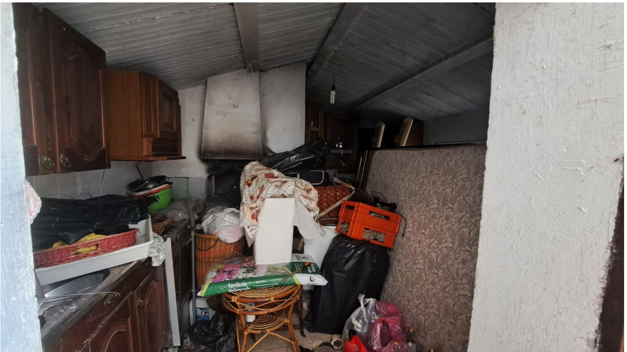
Vedute interne del manufatto ad uso forno (afferente il sub 2)
