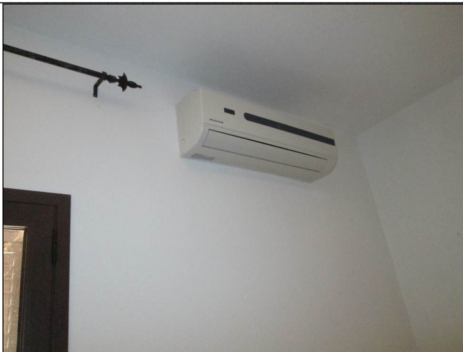
Foto n° 17 – Tipologia split non funzionanti –
