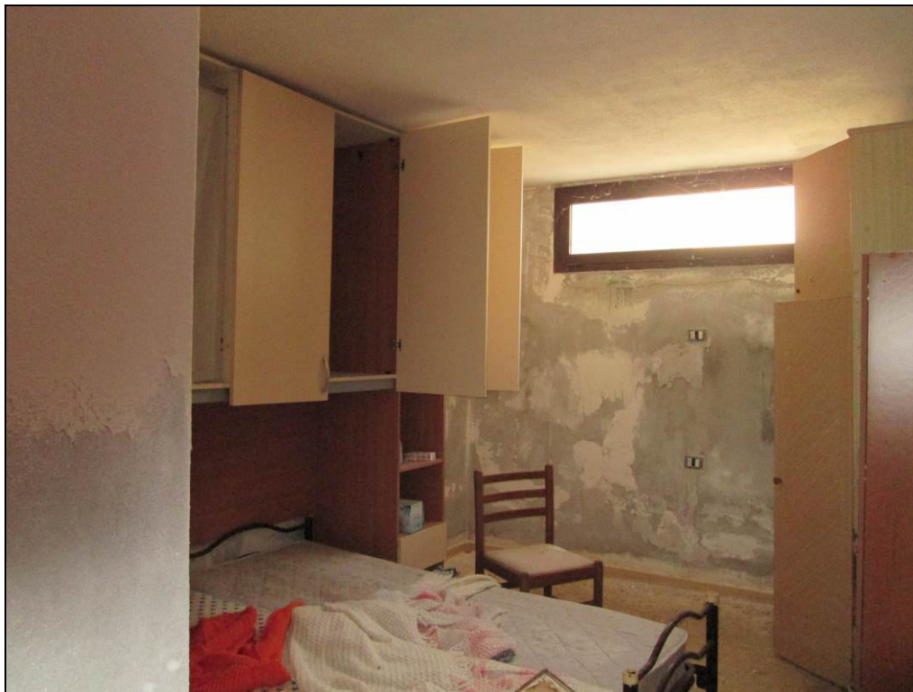
Foto n° 25 – Vista sulla cantina –
