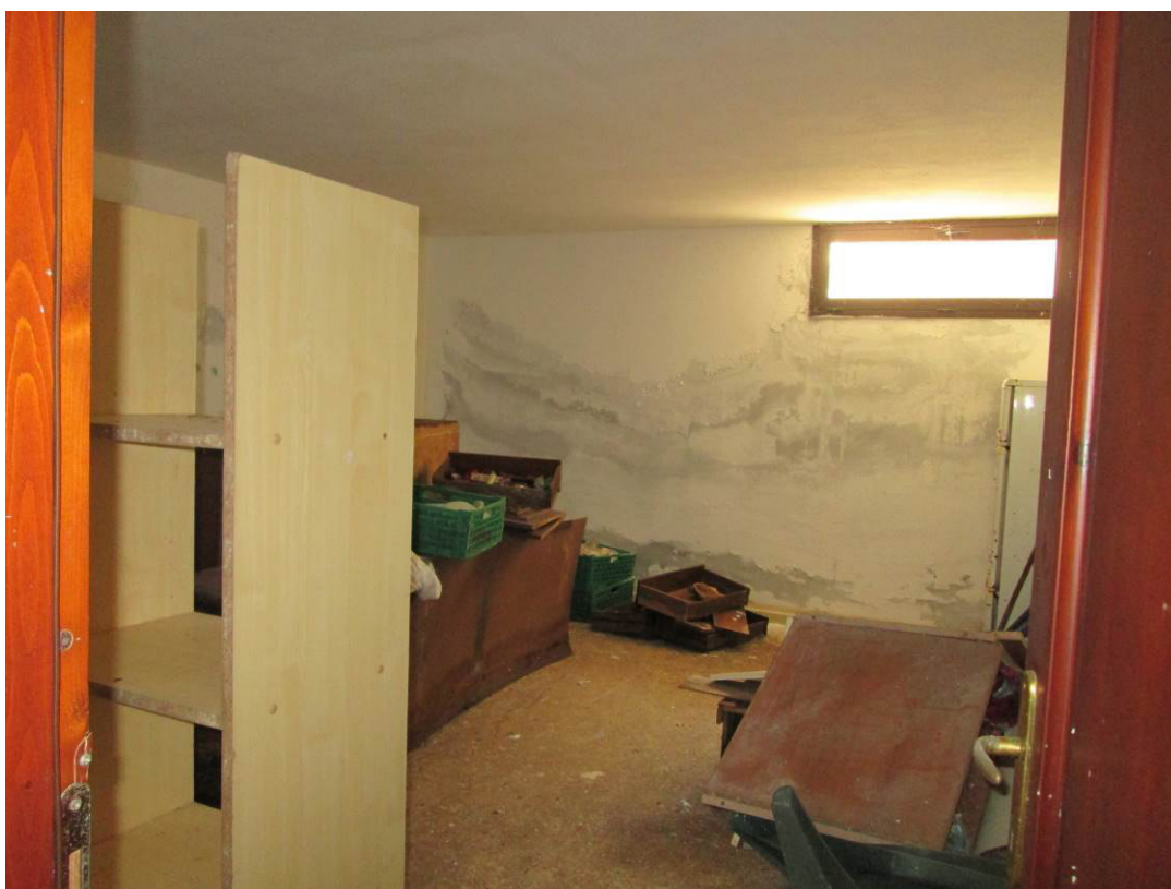
Foto n° 28 – Vista sulla cantina –
