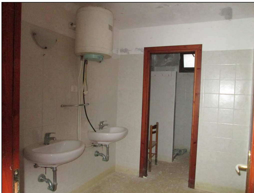
Foto n° 26 – Vista sul bagno –
