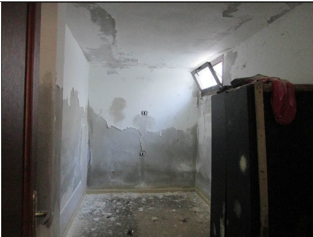
Foto n° 27 – Vista sulla cantina –
