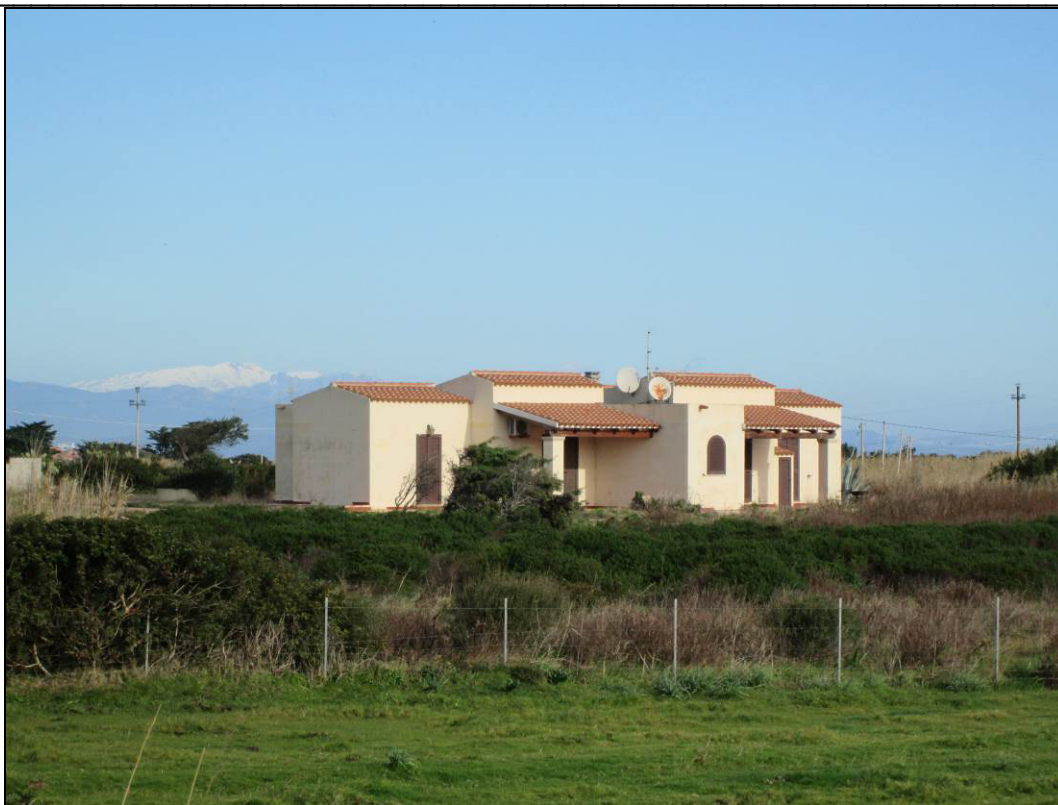
Foto n° 1 – Vista dalla strada di accesso –
