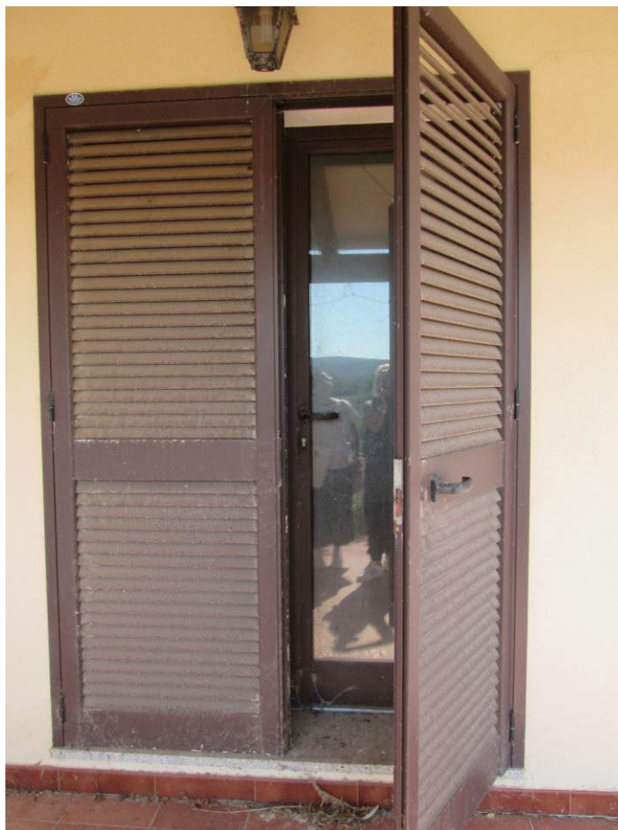
Foto n° 22– Tipologia infissi esterni –
