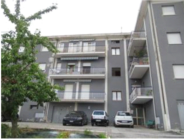
Facciata Ovest - principale
