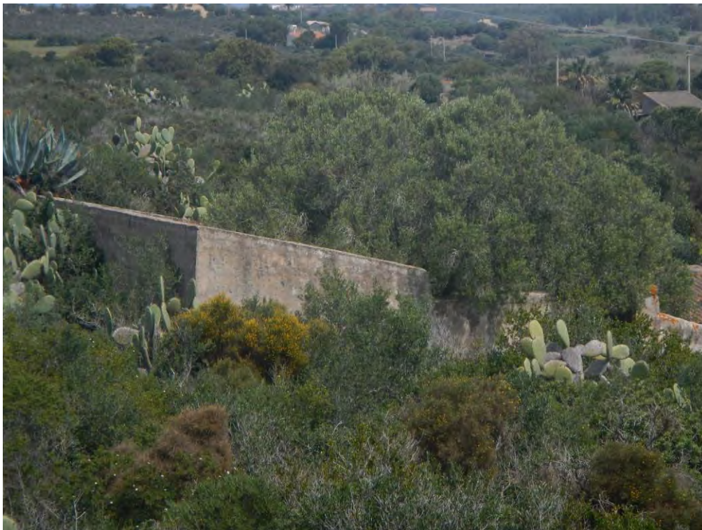
Foto 12: dettaglio edificio in stato di rudere
