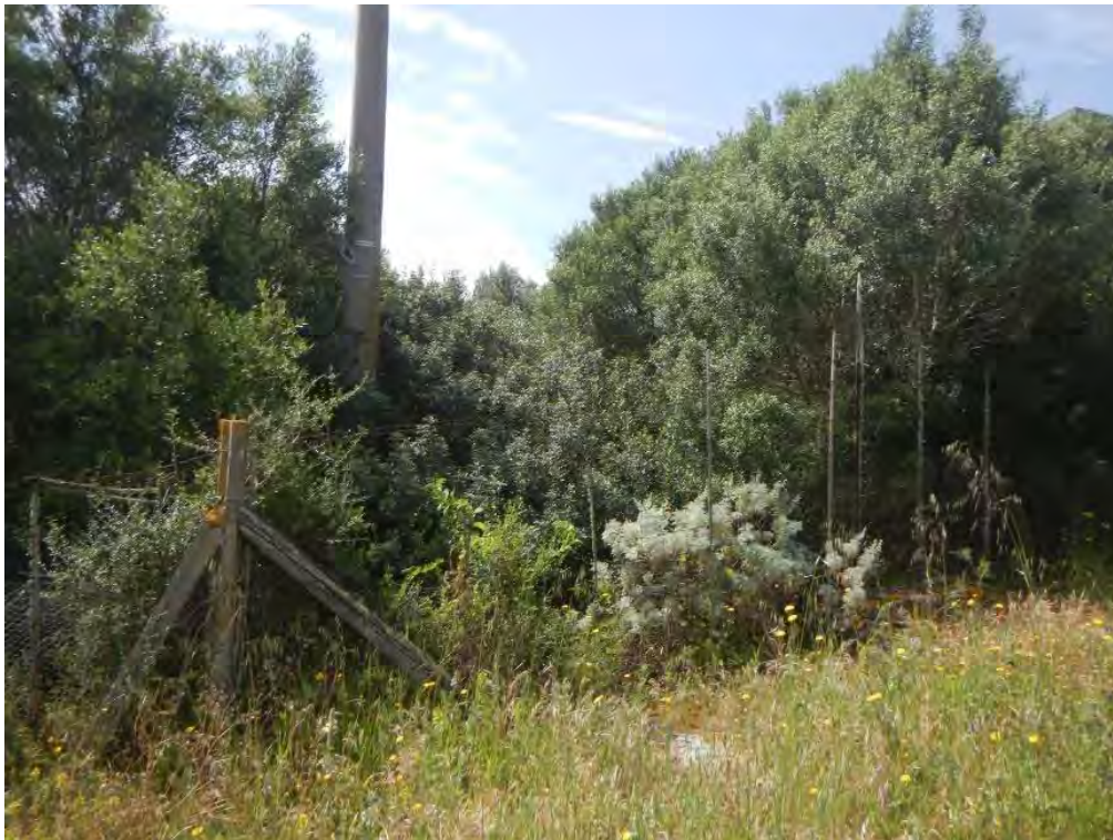
Foto 8: recinzione lato nord
