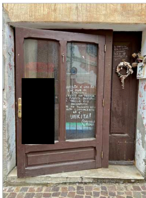
Figura 8 Ingresso Cespite A
