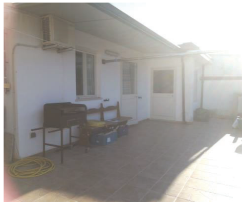
foto 46 – piano copertura vano 1
