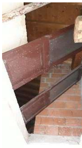
Foto 10: Soffitta garage (al grezzo)
