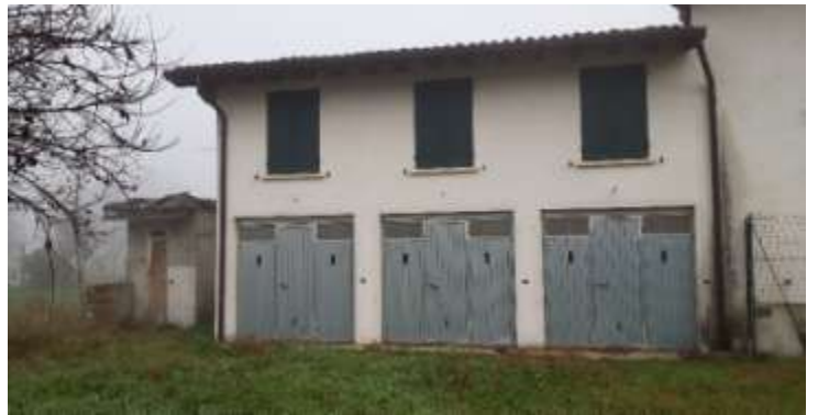
Foto 12: Autorimessa (a sinistra)
