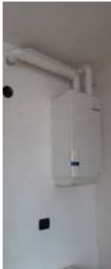
Foto 8: Caldaia murale
