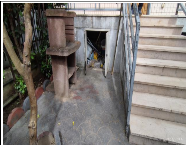
Foto 3 Sottobalcone -creato ripostiglio
