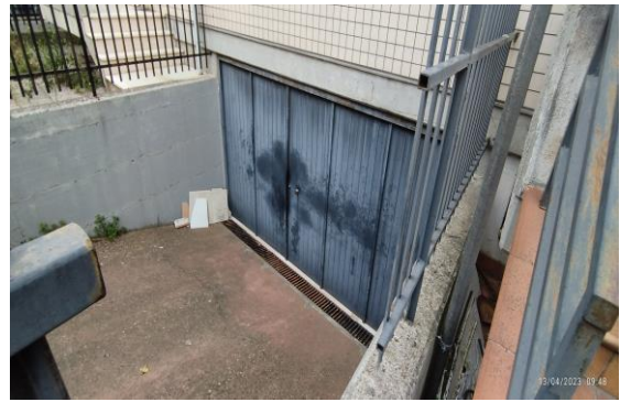
Foto 24. Portone ingresso del box
