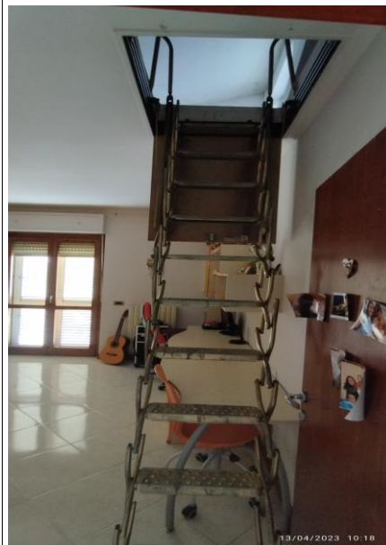
Foto 16. Botola con scale per salire al sottotetto
