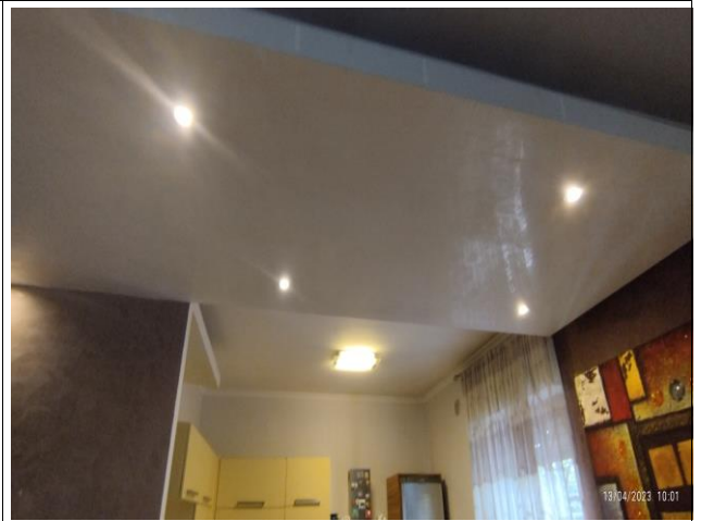
Foto 8: controsoffittatura sala - cucina
