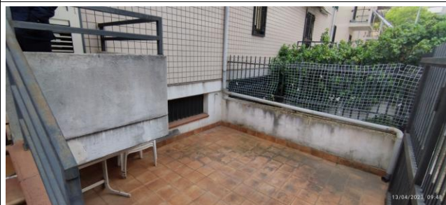
Foto 21. Giardino con accesso da Via Cisterne Pennise
