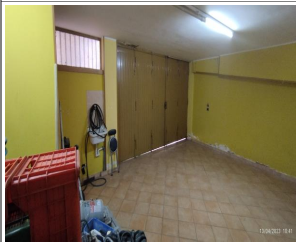
Foto 25 Vista interna del box
