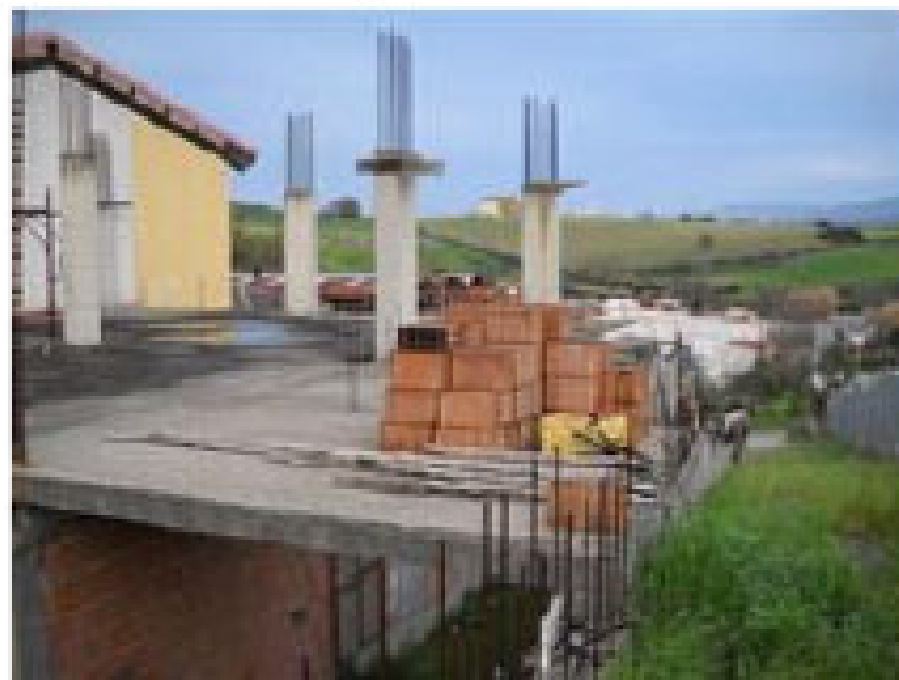
piano primo lastrico solare
