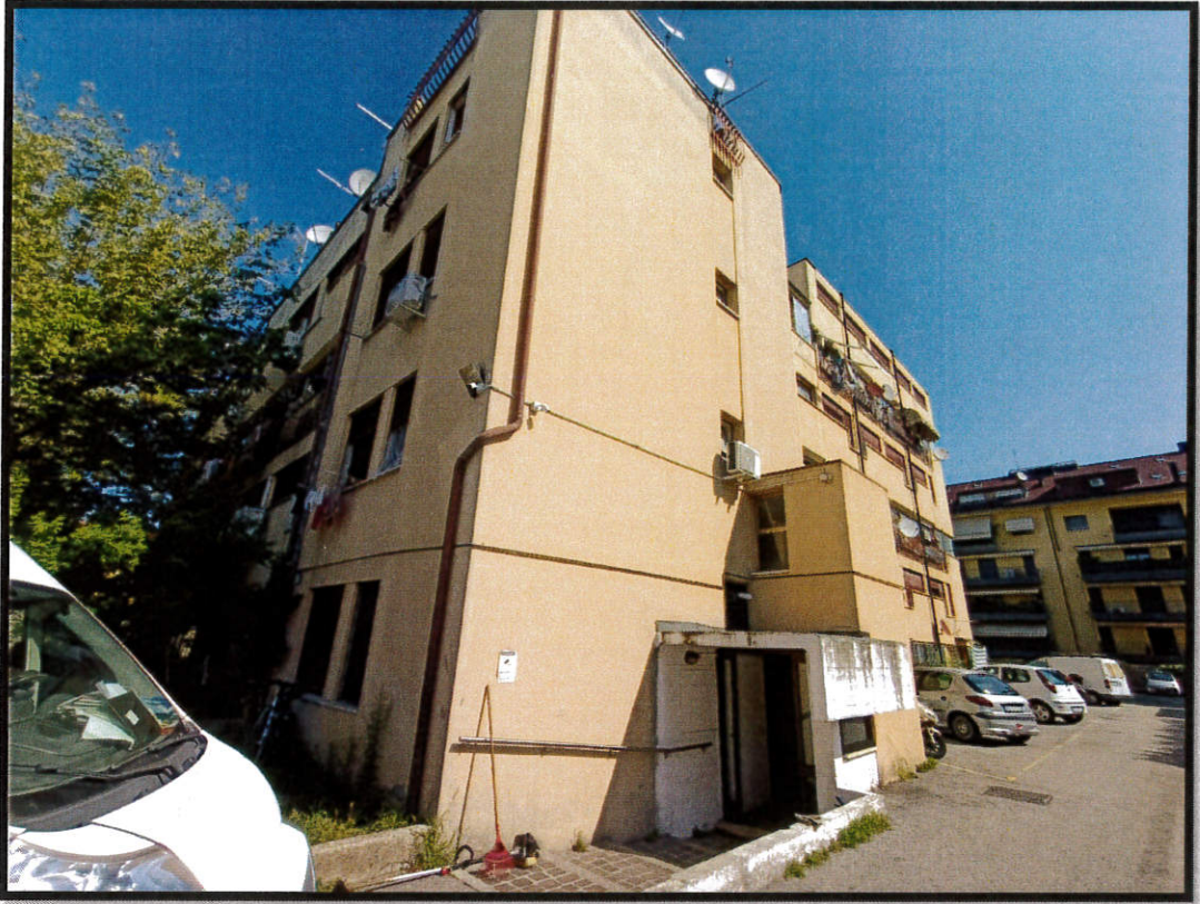
Foto n. 1: Vista ingresso condominiale, prospetto Sud.
