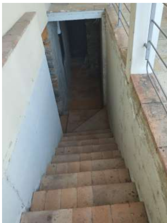
SCALA DI ACCESSO
