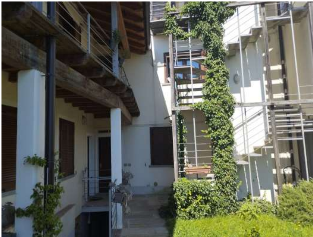
FRONTE PRINCIPALE EDIFICIO La scala a sinistra garantisce l'accesso all'U.I. interrata
