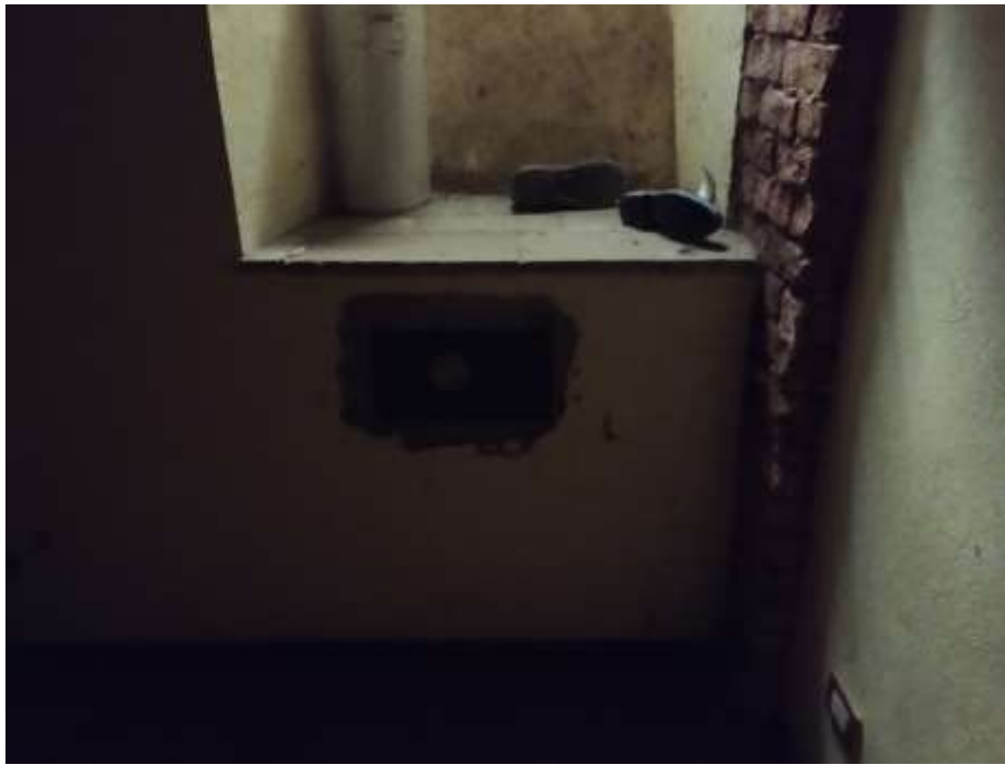
ZONA BAGNO -ARCHIVIO CON CASSAFORTE A MURO
